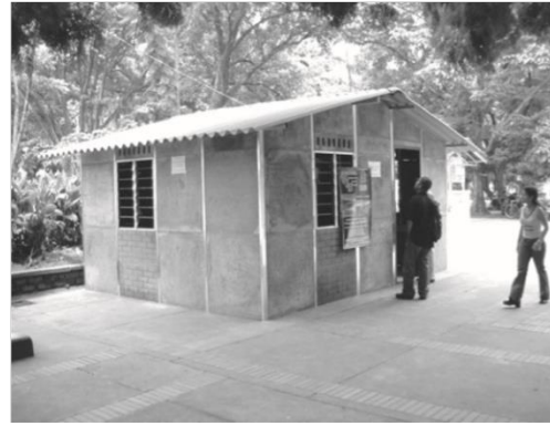
Fotografía 6. Aspecto exterior de la vivienda prefabricada en paneles de concreto reciclado.
