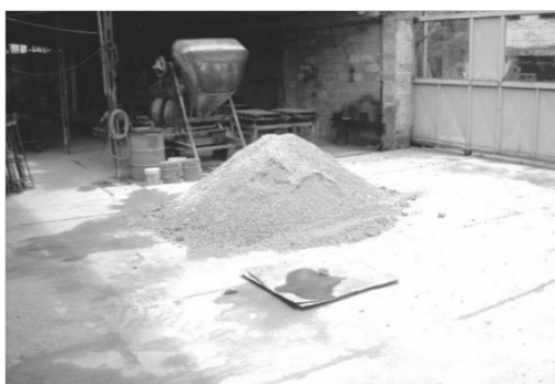
Fotografía 3. Agregados reciclados para una nueva mezcla.
