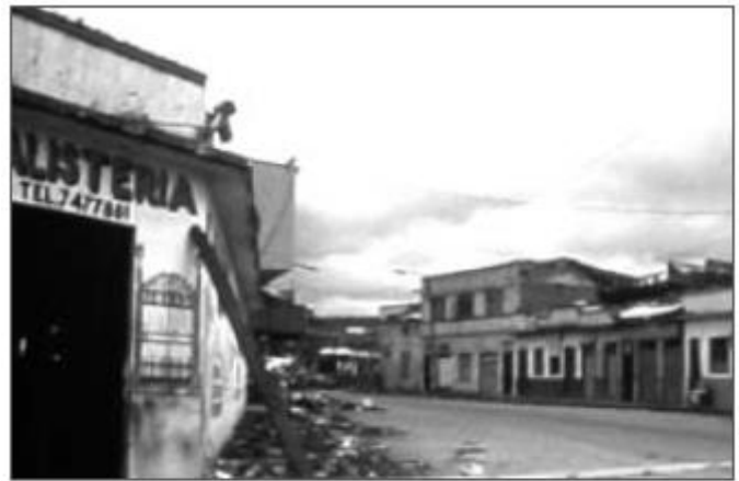
Daños generados por el sismo del 25 de enero de 1999 en Colombia.
