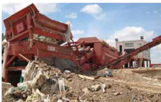
Fotografía N° 10. Planta de reciclado de escombros de San en Almendraremos, España 8 .
