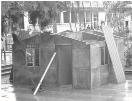
Fotografía 5. Armado de la vivienda prefabricada confeccionada en concreto reciclado.
