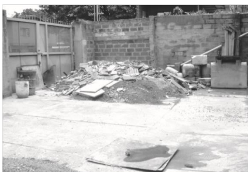
Fotografía 1. Escombros generados en la elaboración de paneles prefabricados.
