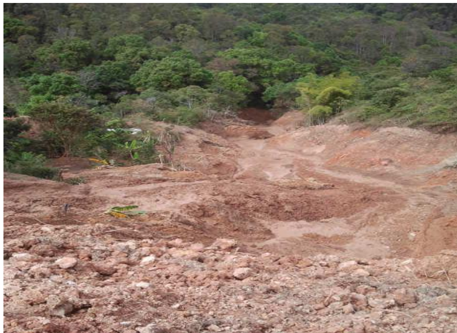
Ilustración 4. Efectos de deslizamiento Sub cuenca del río Molino, año 2013
