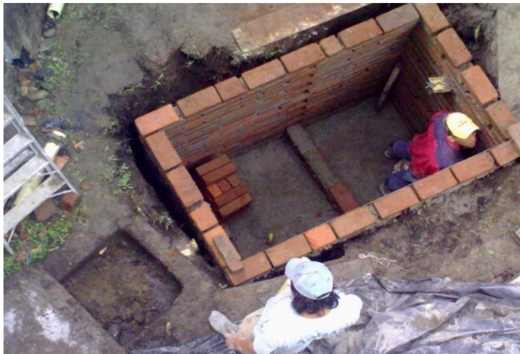
Ilustración 12. Construcción Pozo Séptico, Casa Villa Camila, Vereda San Juan de Carolina.
