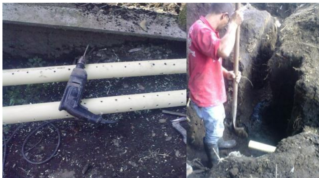
Ilustración 13. Instalación Campo de Infiltración Vivienda Villa Camila, Vereda San Juan de Carolina.
