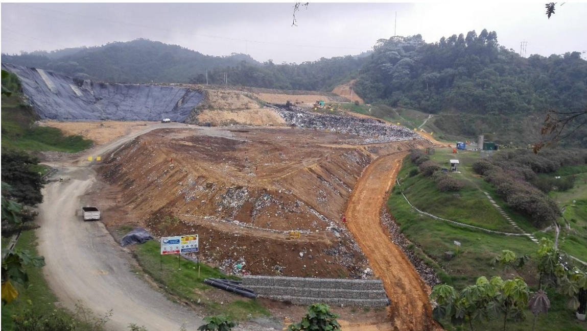
Figura 19 Relleno Sanitario La Esmeralda Municipio de Manizales
