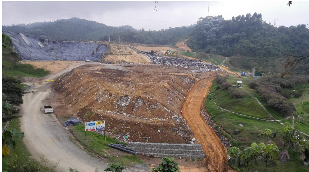
Figura 35 Vista aérea Relleno Sanitario
