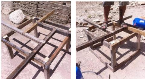
Figura 27 y 28 Estructura reciproca regular sobre el espacio principal de planta rectangular. (Aloe de Sorbas)
