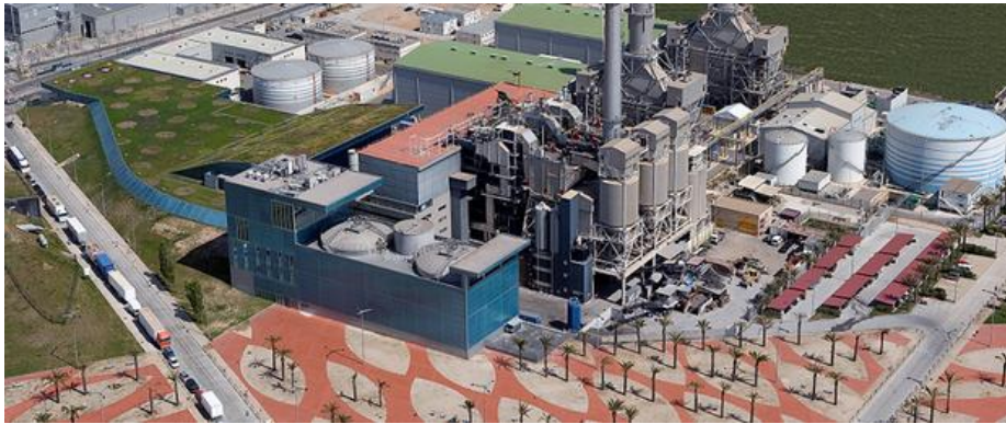
Figura 28 Planta de valorización energética TERSA
