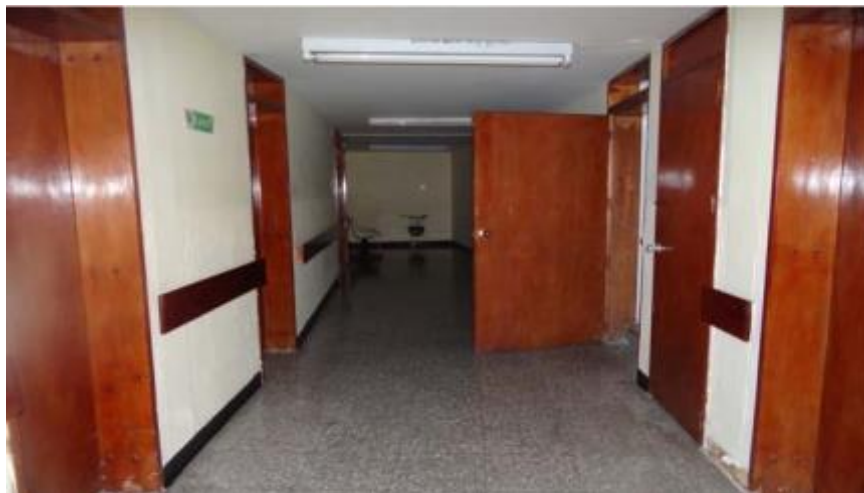
Figura 14. Entrada principal al servicio de Urgencias (cerrado hace aproximadamente 15 años). Actualmente Servicios de consulta Externa.
