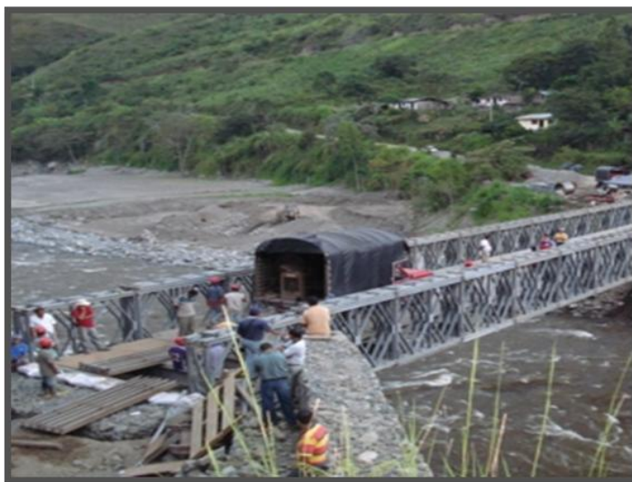
Foto 8. Construcción puente sobre el río Páez en Cohetando (Belalcázar - Popayán y La Plata (Huila))
