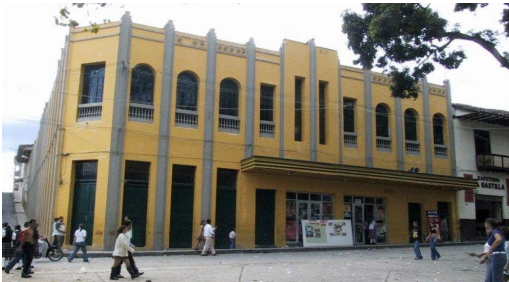
Imagen 3. Fachada teatro municipal de Salamina. Fotografía. (Osorio, 2010).
