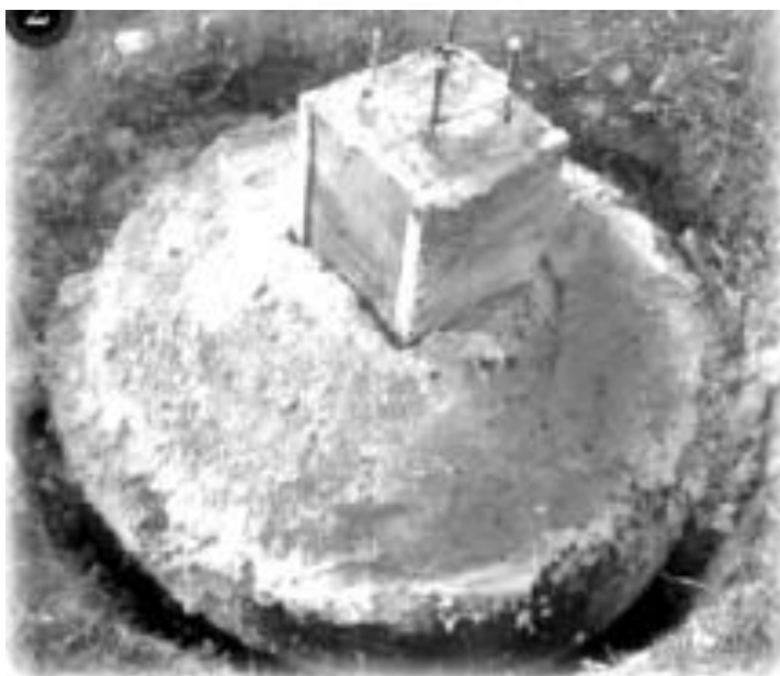
VACIADO DE HORMIGÓN ARMADO
