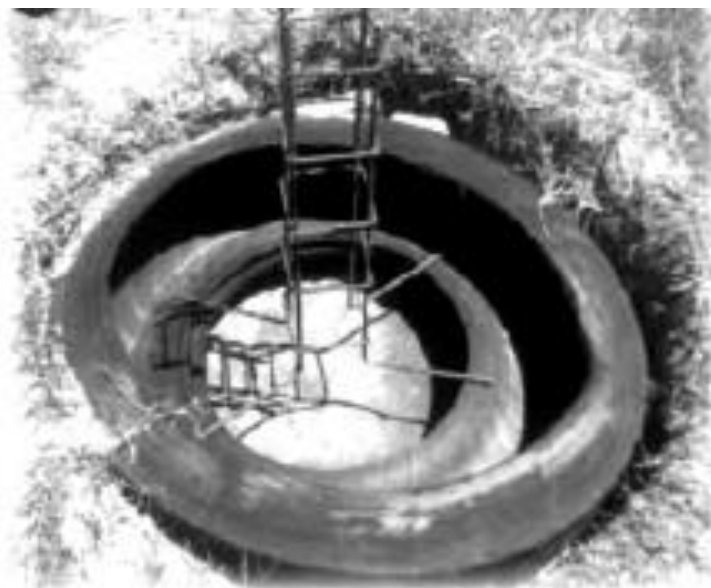
NEUMATICO COMO REFUERZO DE ZAPATA
