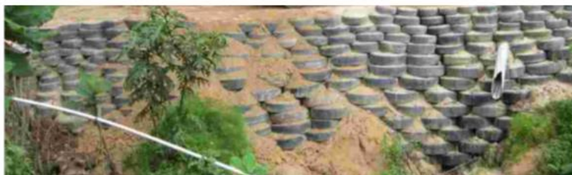
MURO DE CONTENCIÓN CON LLANTAS LA LLANTA COMO MATERIAL ARQUITECTÓNICO
