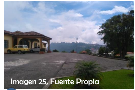
Imagen 25, Fuente Propia 5 Casa de Retiro Villa Kempis
