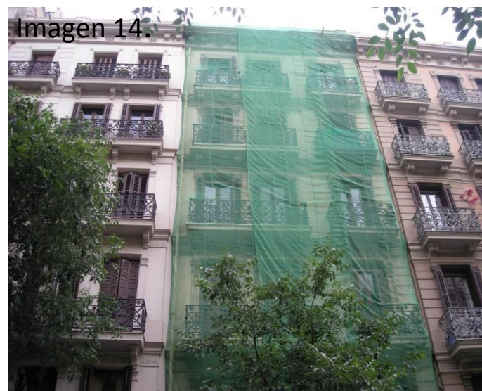
REHABILITACIÓN, RE FUNCIONALIZACIÓN Y AMPLIACIÓN DE EDIFICIOS
