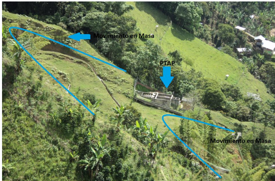
Fotografía 3 Planta de Tratamiento de Agua Potable, Vereda Maracas, Manizales
