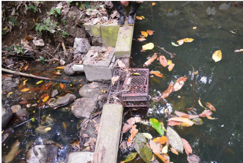
Fotografía 14 Bocatoma del Acueducto de Caimán Nuevo en Necoclí
