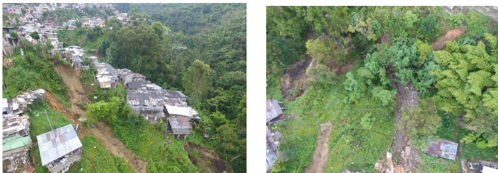
Figura 2. Imágenes del deslizamiento en el sector El Aguacate. Fuente: Propia.
