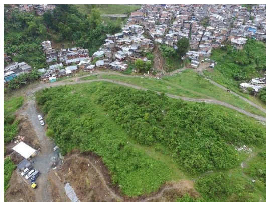
Figura 3. Imágenes del deslizamiento en el sector Bajo Andes. Fuente: Propia.
