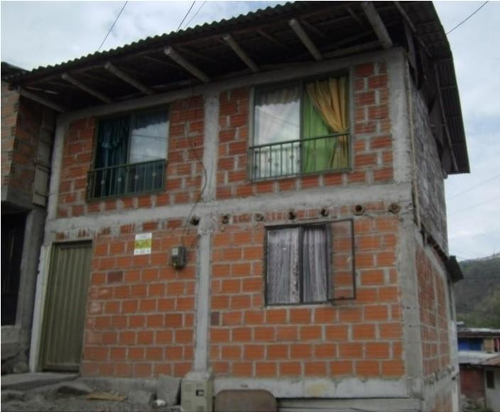
Vivienda con el mismo sistema constructivo anterior, con entepiso en estructura en guadua y cubierta en guadua con teja de fibrocemento.
