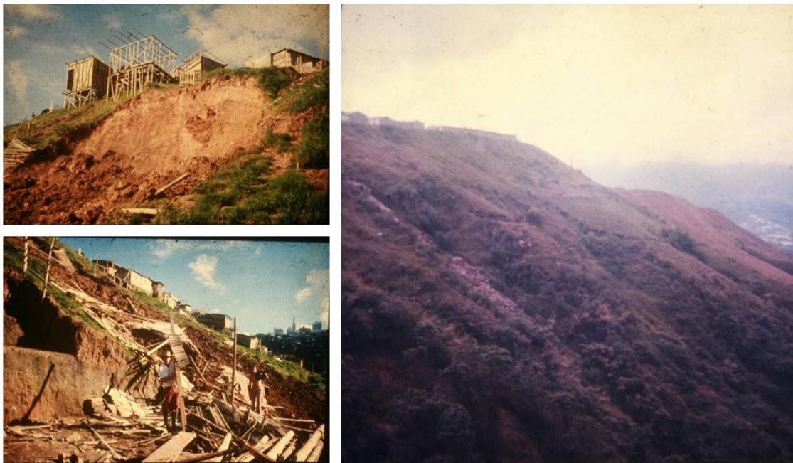
Ilustración 21 Movimiento en masa en la corona de la ladera año 1987 Fuente: Archivo fotográfico Ingeniero Carlos Enrique Escobar Potes
