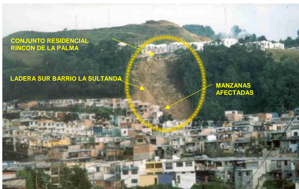
Figura 85 Escarpe del deslizamiento (Procolombia, 2014)
