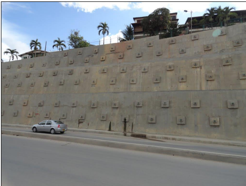
Figura 72 Muro anclado Girón, Santander, Colombia (Ardila, 2.011)
