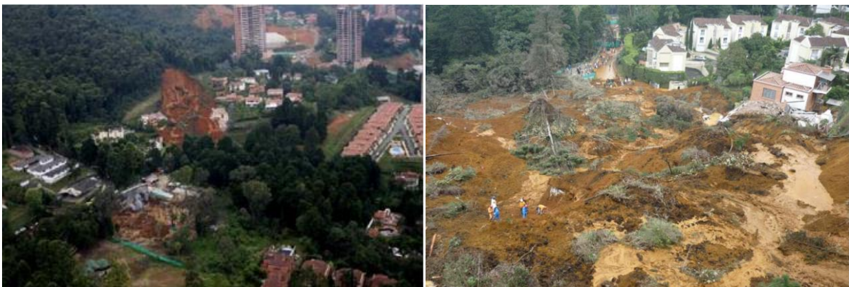
Figura 78 Daños causados por el deslizamiento al conjunto residencial de estrato 6 en el Poblado, Medellín. (LOPEZ, 2008)
