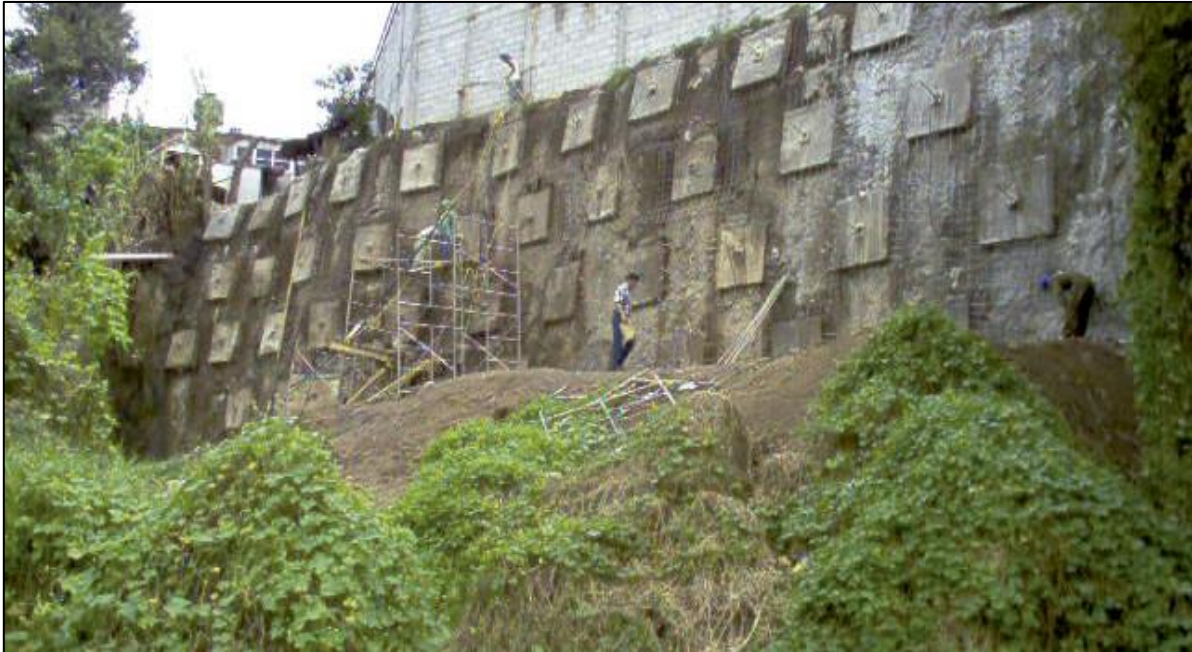
Figura 76 Muro anclado en la barranca de Xonacantepec, Puebla. Proceso de tensado (TECSA, s.f.)
