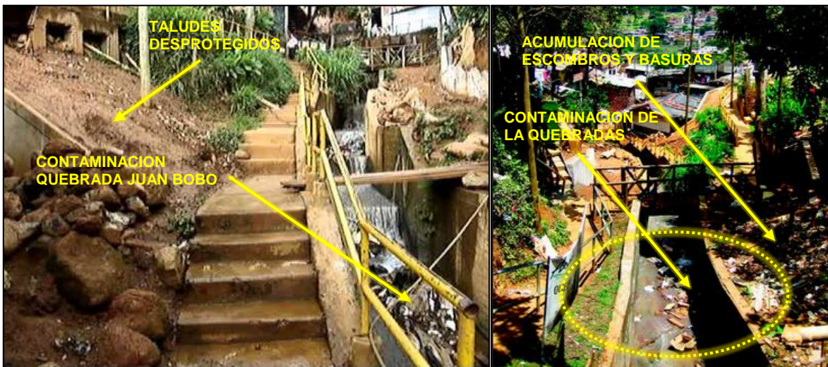
Figura 93 Entorno en alto riesgo por deslizamiento- Antes de la intervención (Tirado, Ing. Carlos Ignacio Uribe, s.f.)
