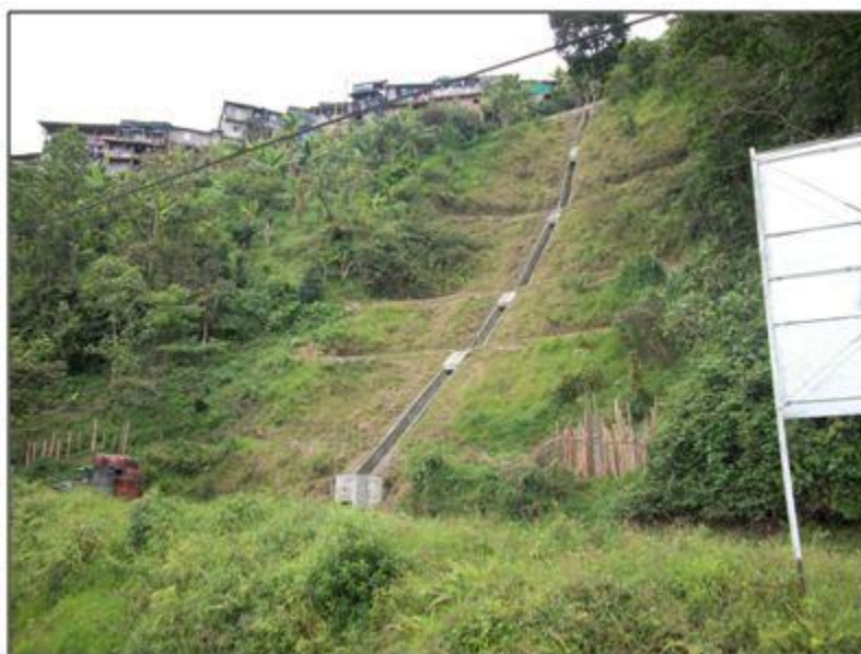
Figura 50 Esquema de entrega de canales interceptores a mitad de talud (Suarez Díaz, Deslizamientos y estabilidad de taludes en zonas tropicales, 1.998)
