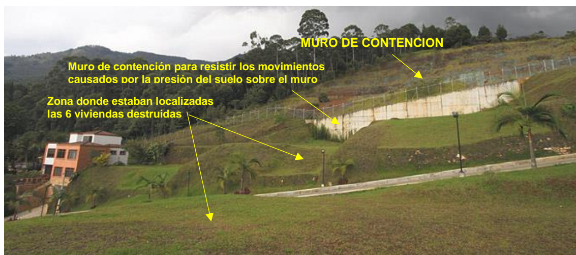
Figura 84 Se observa el trabajo materializado que perfila cada espacio del terreno finalizando con el muro de contención y demás cortes. (vivirenel poblado, 2012)
