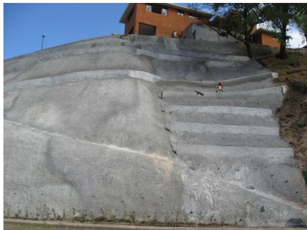
Figura 43 Concreto lanzado La Joya, Guatemala (PILOTECMAR, 2009)
