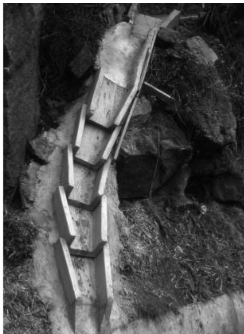
Figura 53 Canal con disipadores de energía tipo gradería (Suarez Díaz, DESLIZAMIENTOS TOMO II: TECNICAS DE REMEDIACIÓN, 2.009)
