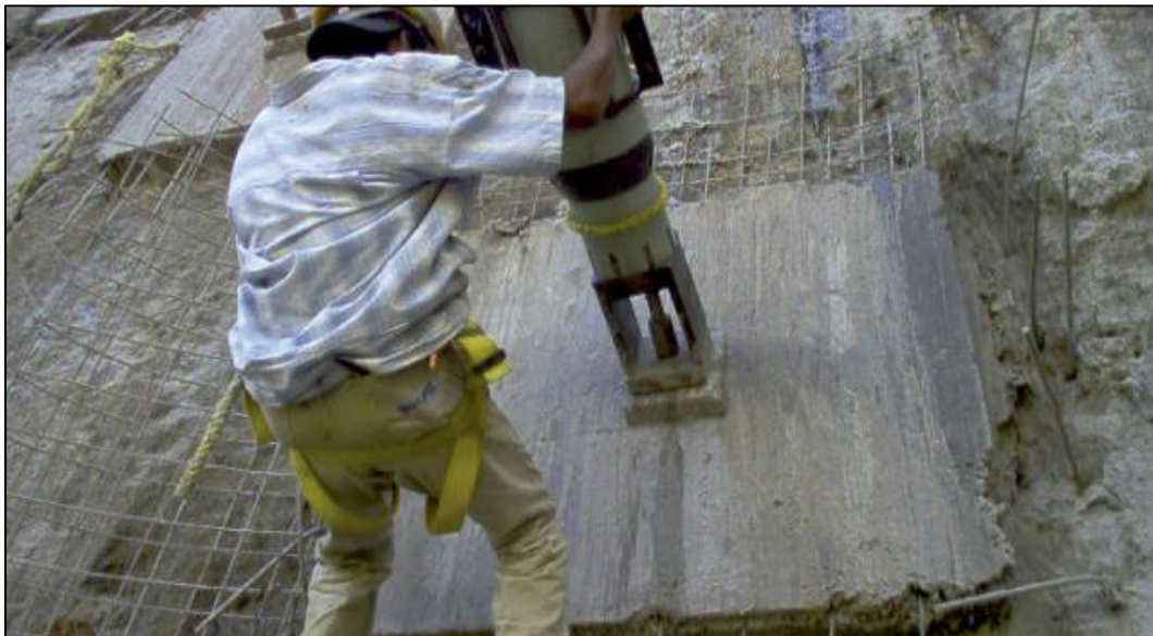
Figura 75 Muro anclado en la barranca de Xonacantepec, Puebla. Proceso de tensado (TECSA, s.f.)
