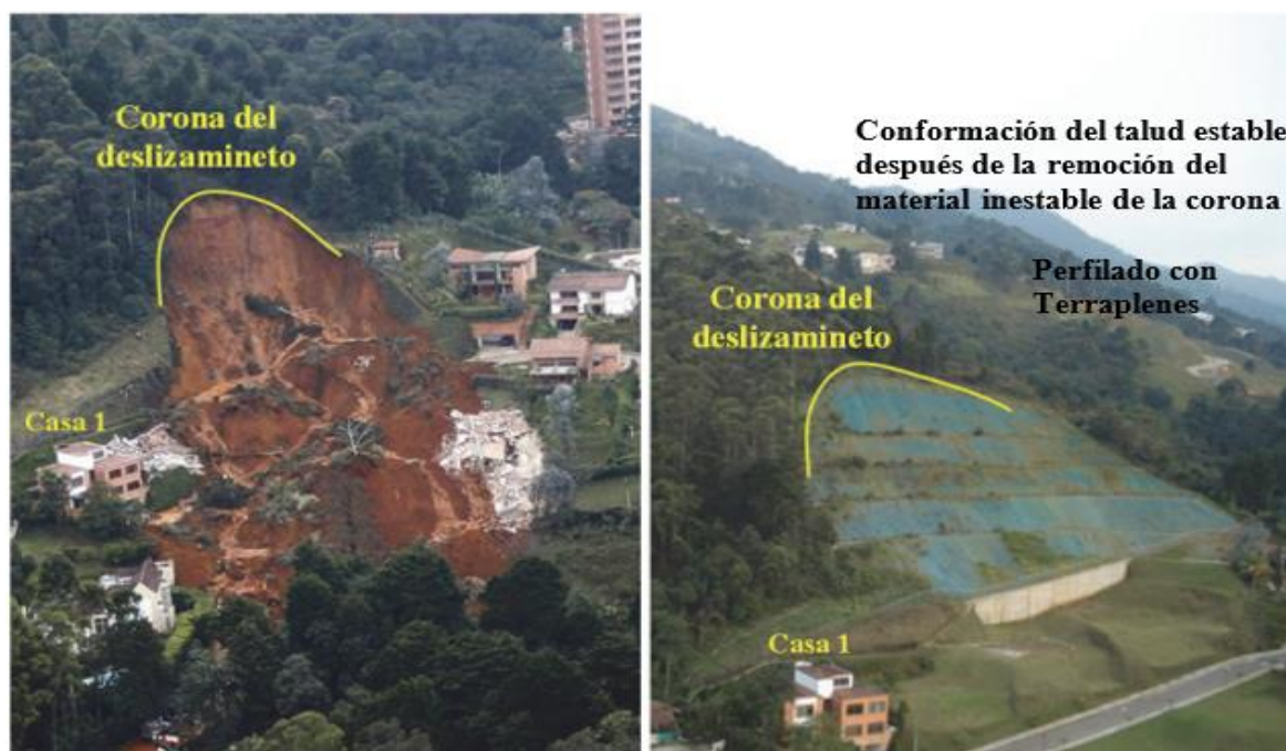
Figura 81 Paralelo general antes y después de ejecutar las obras de estabilización (medidas estructurales) para la mitigación del riesgo por deslizamiento (LOPEZ, 2008)
