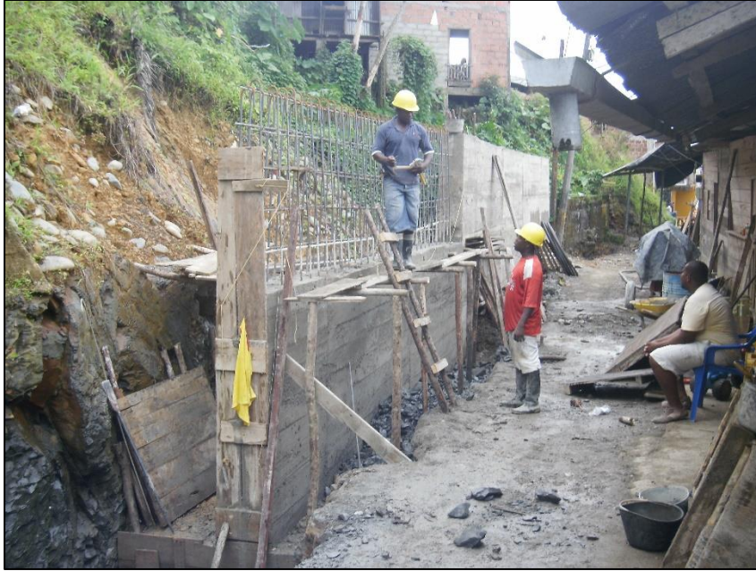
Figura 59 Muro en concreto reforzado barrio Cabecera Sector Chmblum, Municipio de Condoto, Chocó (ALCALDÍA DE CONDOTO - CHOCÓ, 2011)
