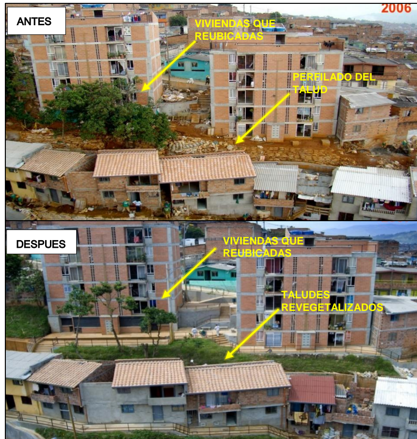
Figura 97 Estado previo a la intervención, y Finalización del Entorno intervenido por las medidas estructurales llevadas a cabo para mitigar el riesgo por deslizamiento (Tirado, Ing. Carlos Ignacio Uribe, s.f.)
