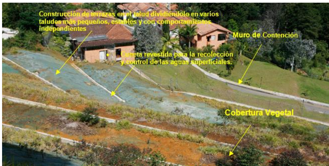
Figura 83 Relación entorno y conjunto de medidas estructurales llevadas a cabo para la seguridad y confort de la zona residencial (vivirenel poblado, 2012)
