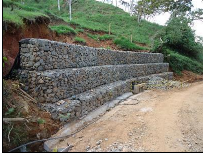
Figura 64 Muro en gaviones (INGENIERIA, 2015)
