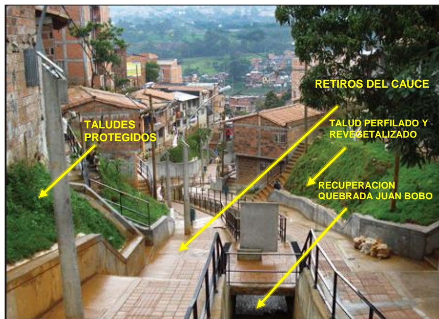
Figura 95 Mejoramiento del entorno para mitigar el riesgo por deslizamiento en las laderas sensibles de la Q. Juan Bobo (Tirado, Ing. Carlos Ignacio Uribe, s.f.)
