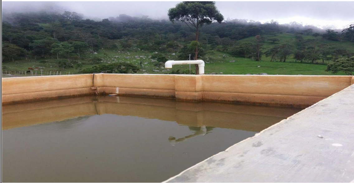
Figura 26. El tanque de almacenamiento distribuye agua para el resto de la finca, utilizando la gravedad.
