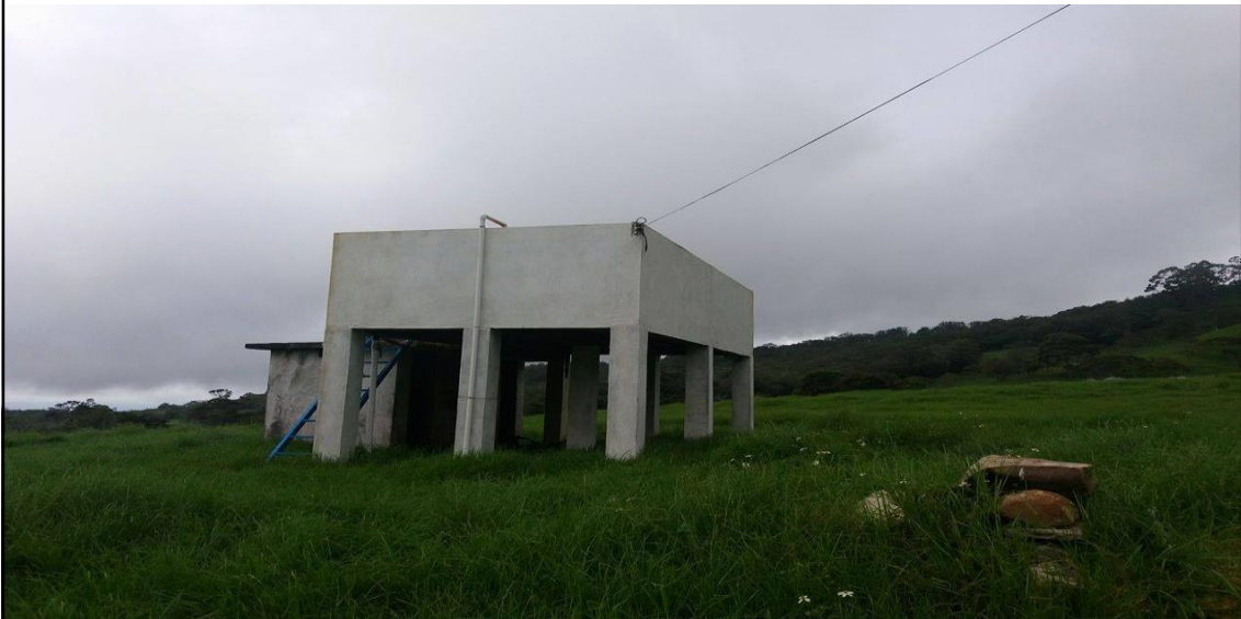
Figura 24. El agua es bombeada hasta un tanque que se encuentra a 1,50 metros de diferencia a donde se ubica el pozo, cuenta con nueve columnas de concreto y varillas de hierro.
