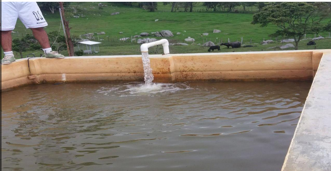
Figura 25. El agua bombeada es regulada por un flotador automático que enciende la motobomba en el momento que el nivel del agua calibrado baja
