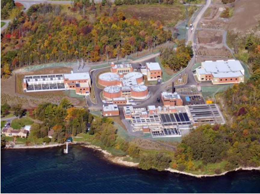
Imagen 24. Ravensview Water Pollution Control Plant – Canadá.
