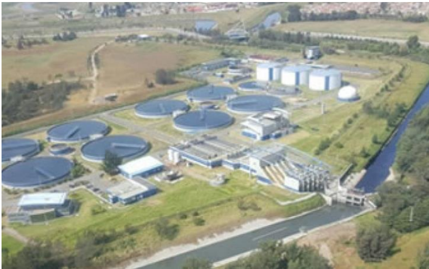
Imagen 14. Planta de Tratamiento de Agua Residual El Salitre.
