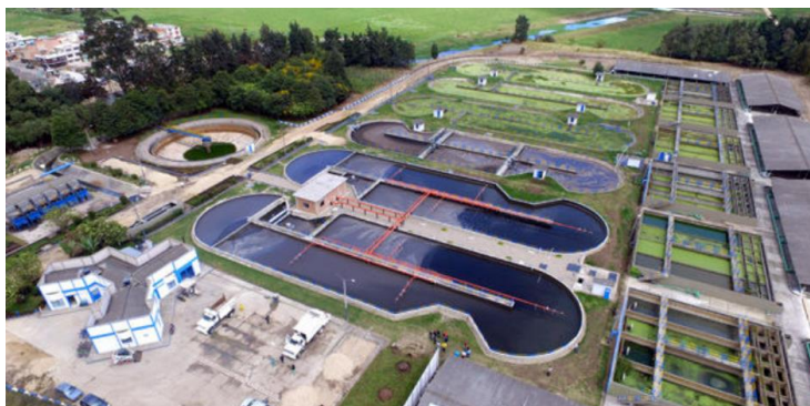
Imagen 12. Planta de Tratamiento de Aguas Residuales del Municipio de Funza.
