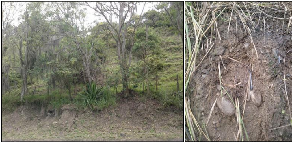
Fotografía 17. Detalle de los afloramientos de depósitos coluviales y de terraza observados en el sitio crítico 7. (Fuente: Elaboración propia).
