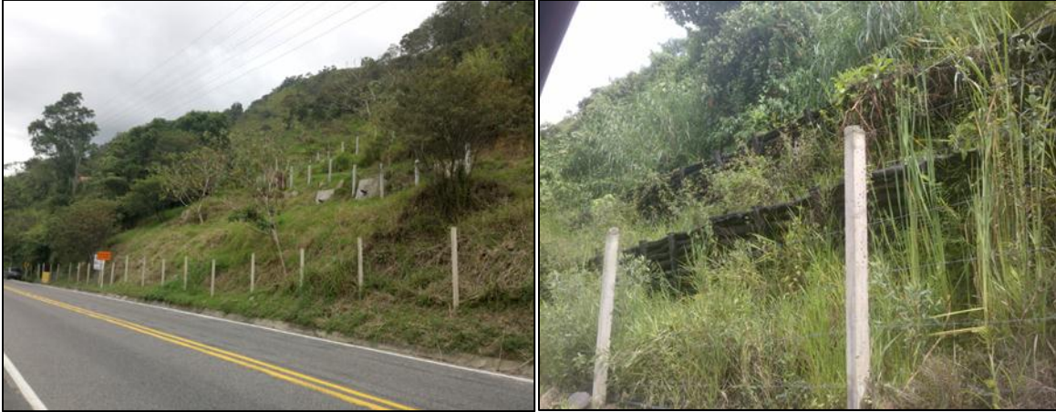
Fotografía 10. Detalle de las obras de estabilidad del talud en el sitio crítico 4. (Fuente: Elaboración propia).
