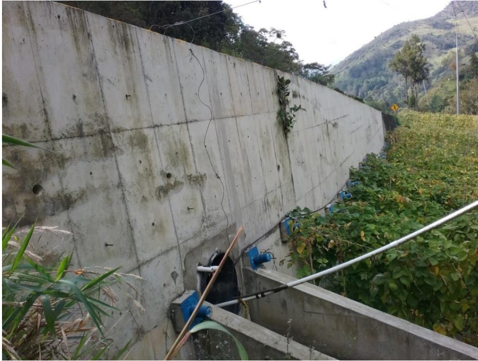
Fotografía 25. Detalle del muro anclado en el sitio crítico 10. (Fuente elaboración propia).
