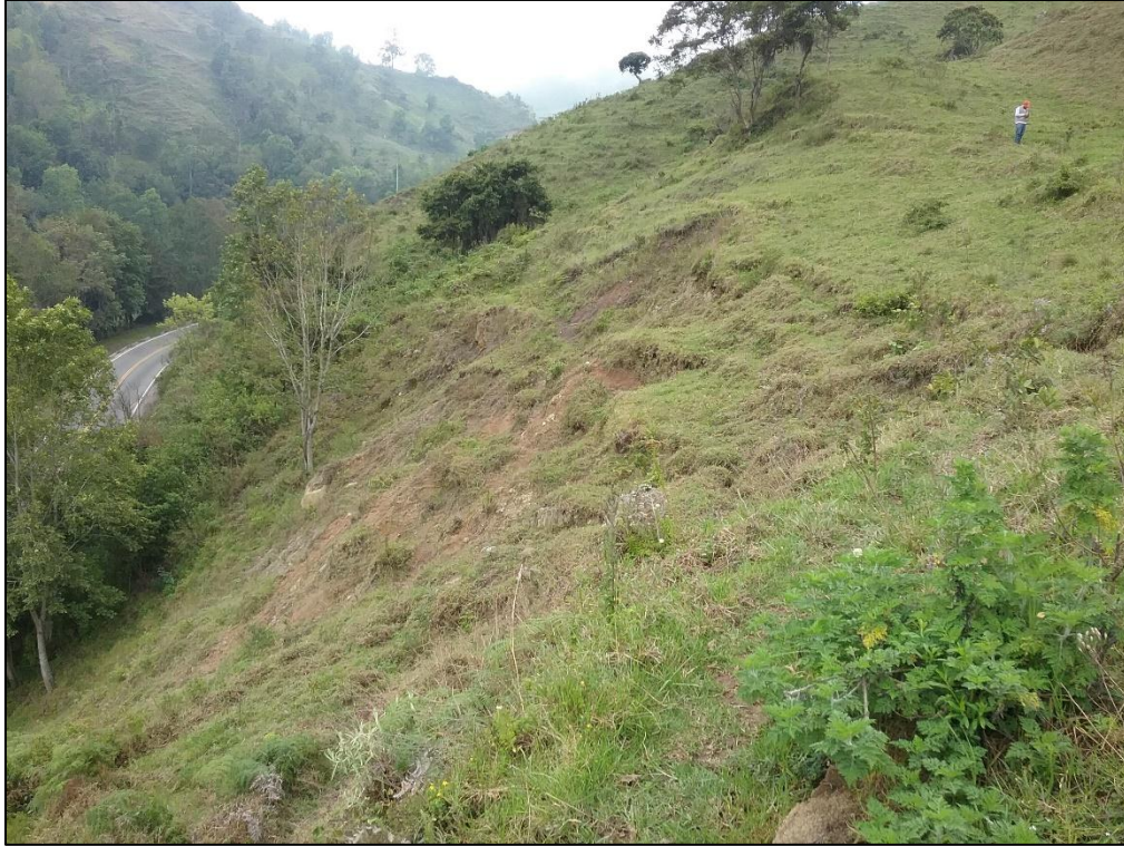
Fotografía 39. Vista general del sitio crítico 14. (Fuente: elaboración propia)
