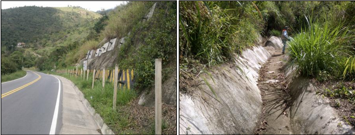
Fotografía 15. Detalle de los anclajes y las cunetas observados en el sitio crítico 6. (Fuente: Elaboración propia).
