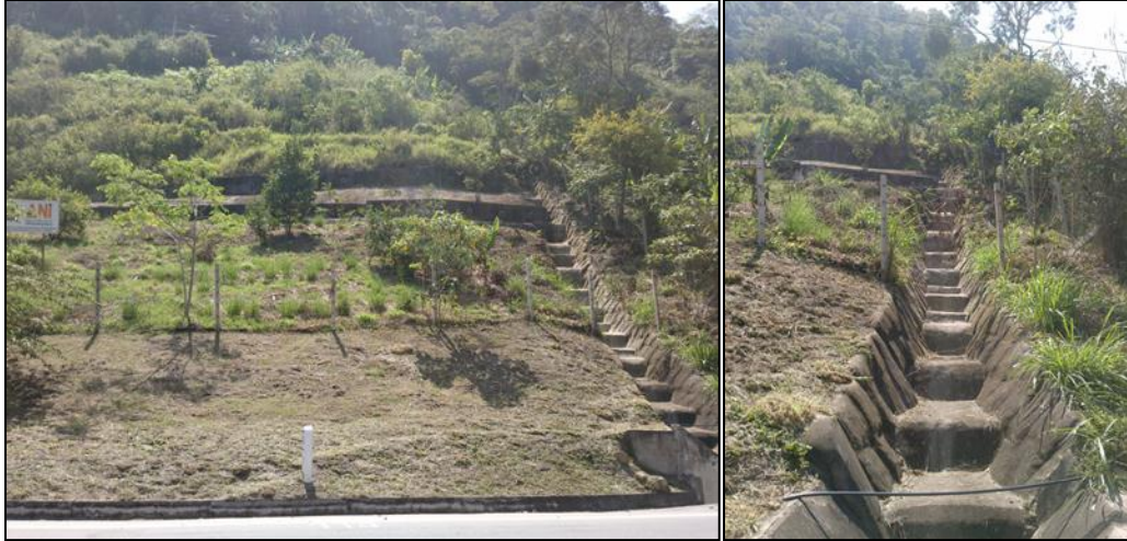
Fotografía 3. Obras de control de aguas entre el sitio crítico 2. (Fuente: Elaboración propia).
