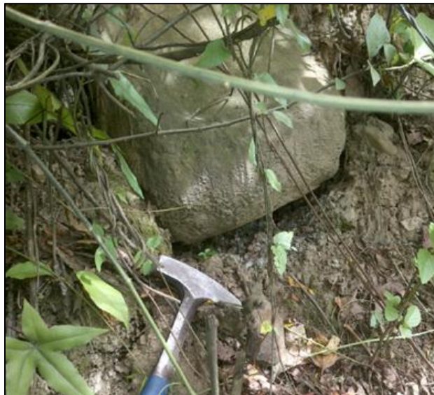
Fotografía 5. Detalle de bloques de arenisca en la terraza aluvial sostenida con malla de alambre de doble torsión. (Fuente: Elaboración propia).
