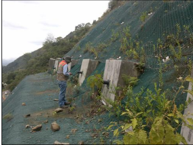
Fotografía 18. Detalle de los anclajes del sitio crítico 7. (Fuente: Elaboración propia).
