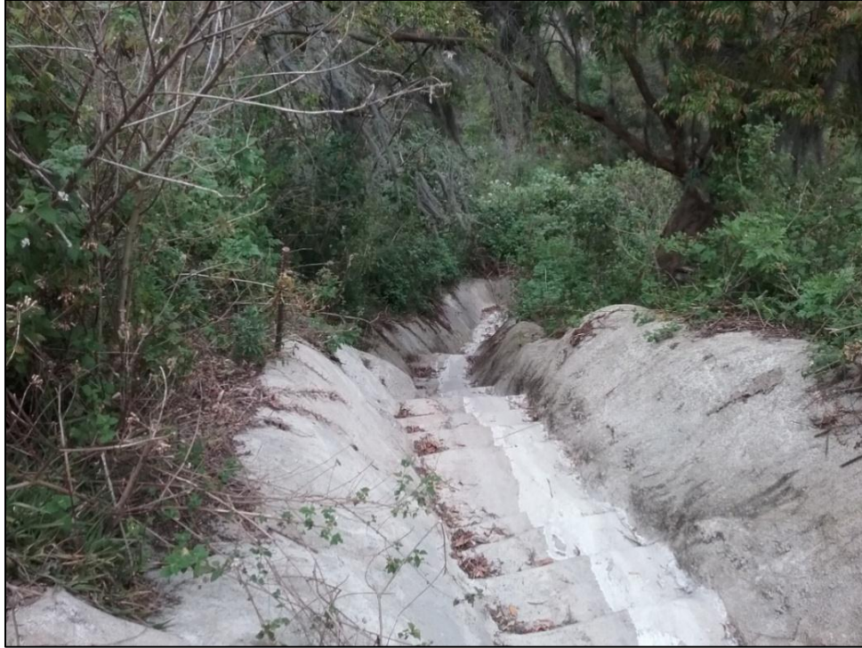
Fotografía 31. Cunetas revestidas (Fuente elaboración propia)
