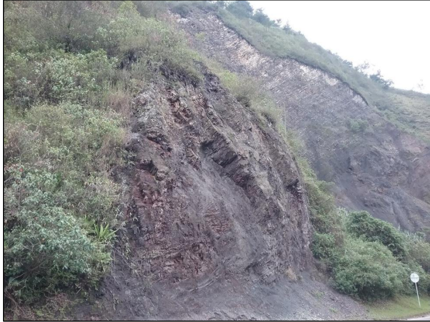
Fotografía 45. Aspecto del primer tramo de 30 metros del sitio crítico 16. (Fuente: elaboración propia)
