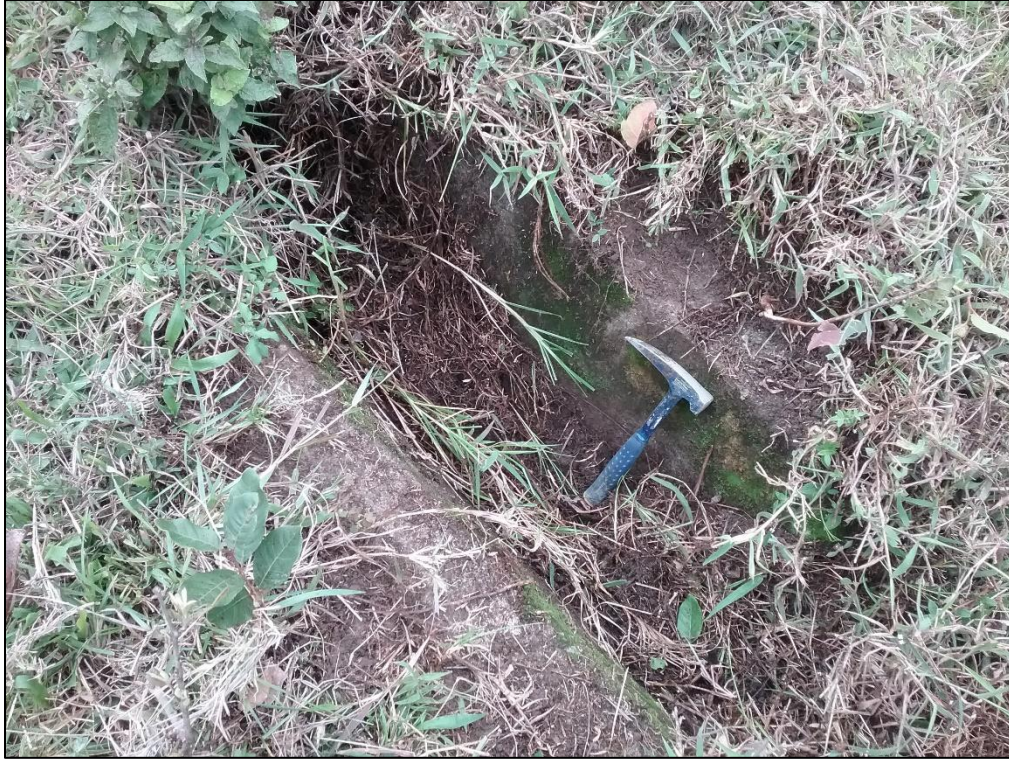
Fotografía 37. Detalle de la cuneta en coronación. (Fuente: elaboración propia)
