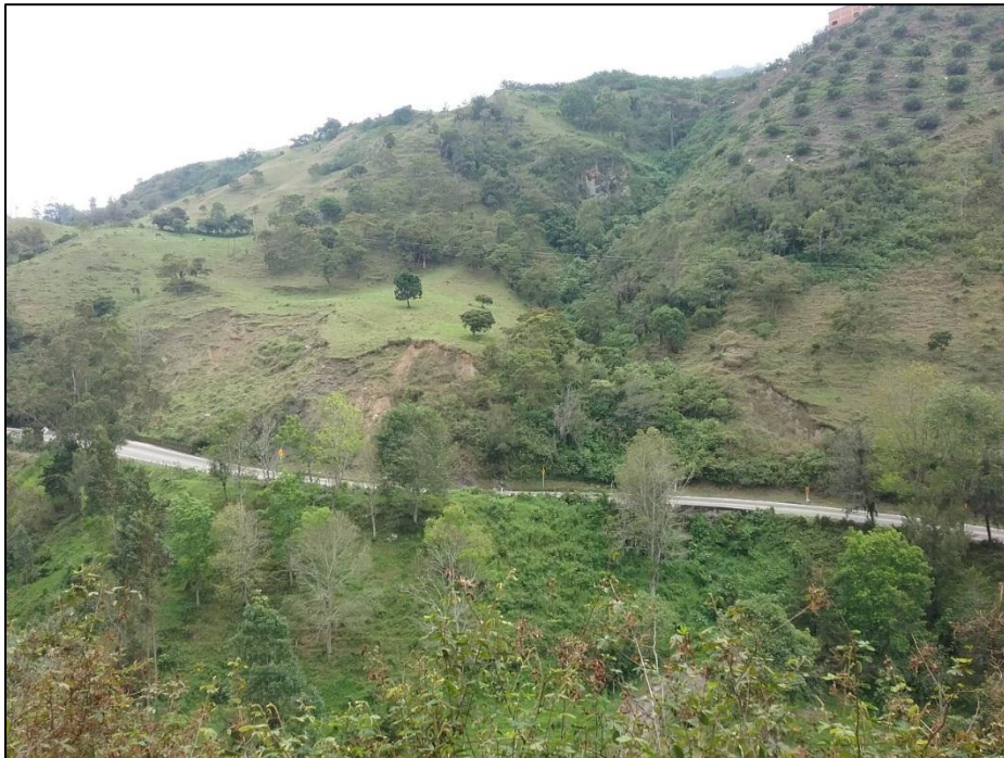
Fotografía 33. Vista de la inestabilidad del sitio crítico 14. (Fuente: elaboración propia)
