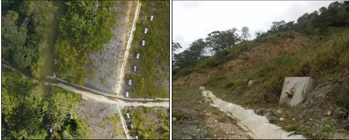
Fotografía 12. Detalle del sistema de anclajes observado en el sitio crítico 5. (Fuente: Elaboración propia).
