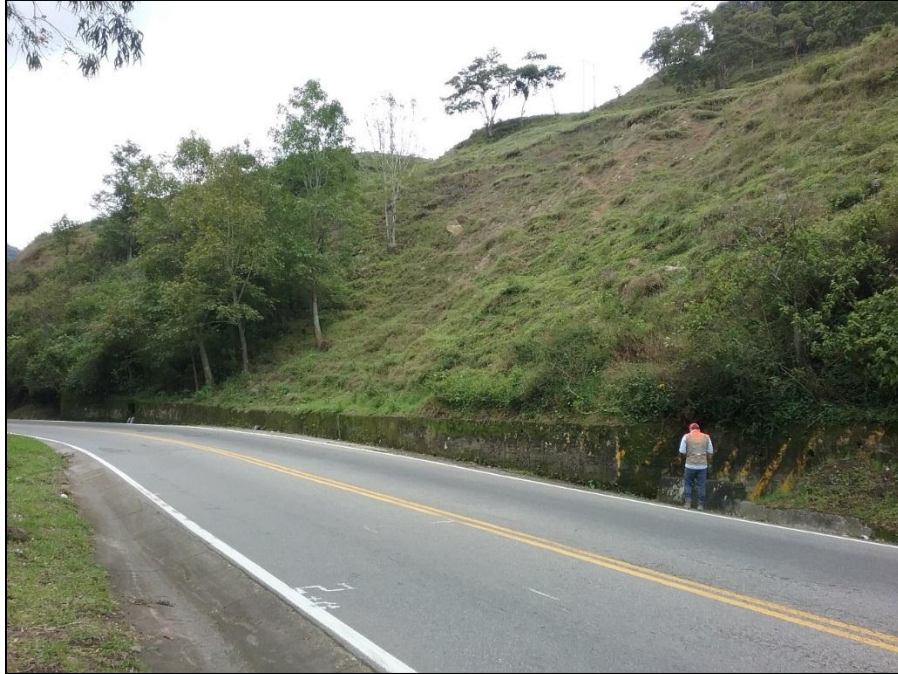
Fotografía 34. Detalle del muro en concreto. (Fuente: elaboración propia)
