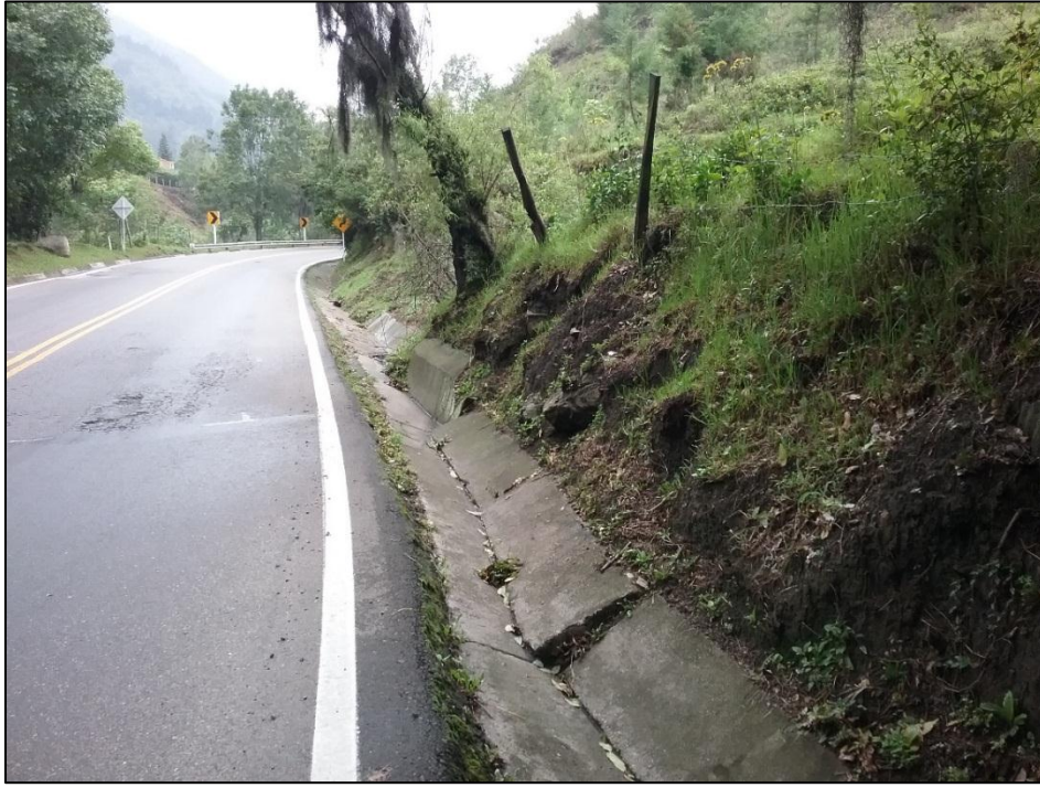
Fotografía 41. Detalle de cuneta con deformaciones antiguas. (Fuente: elaboración propia)
