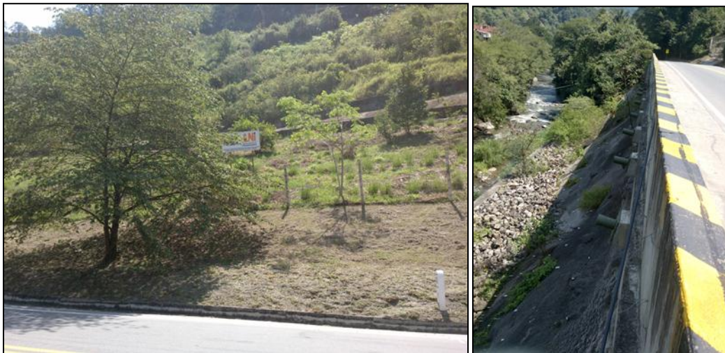
Fotografía 4. Obras de estabilidad entre el sitio crítico 2. (Fuente: Elaboración propia).
