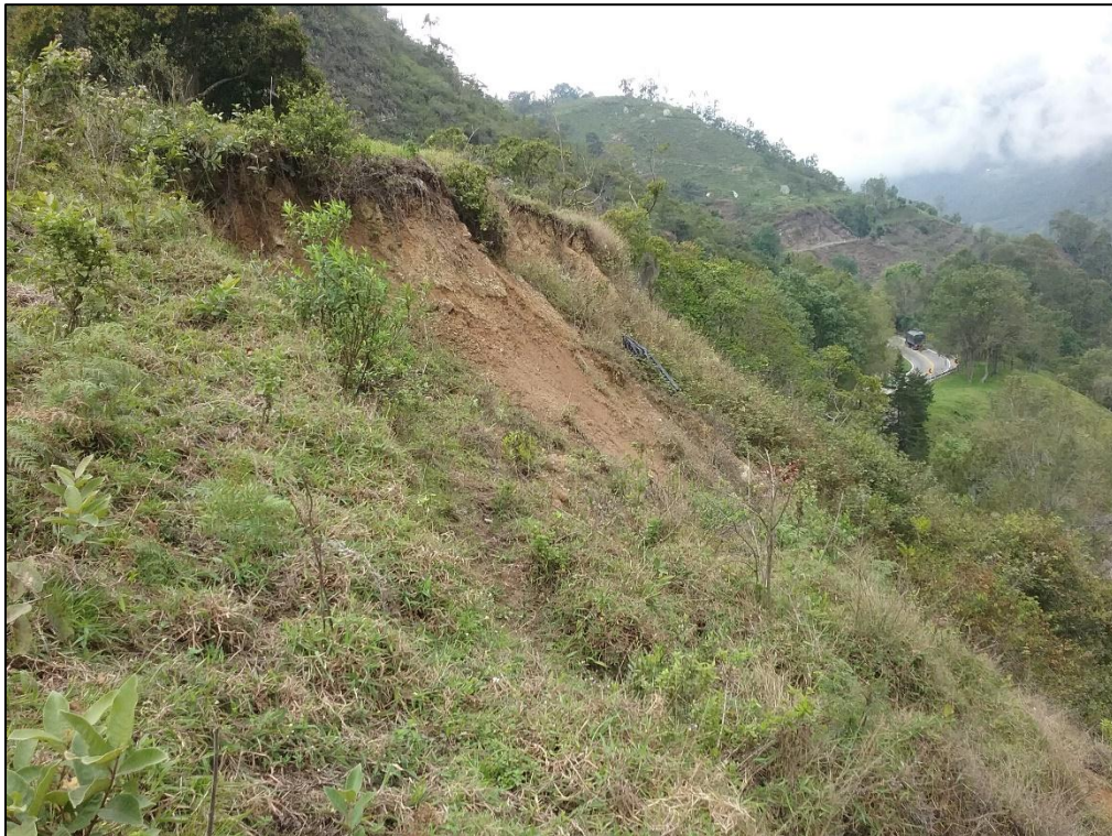
Fotografía 38. Detalle de la corona de deslizamiento. (Fuente: elaboración propia)
