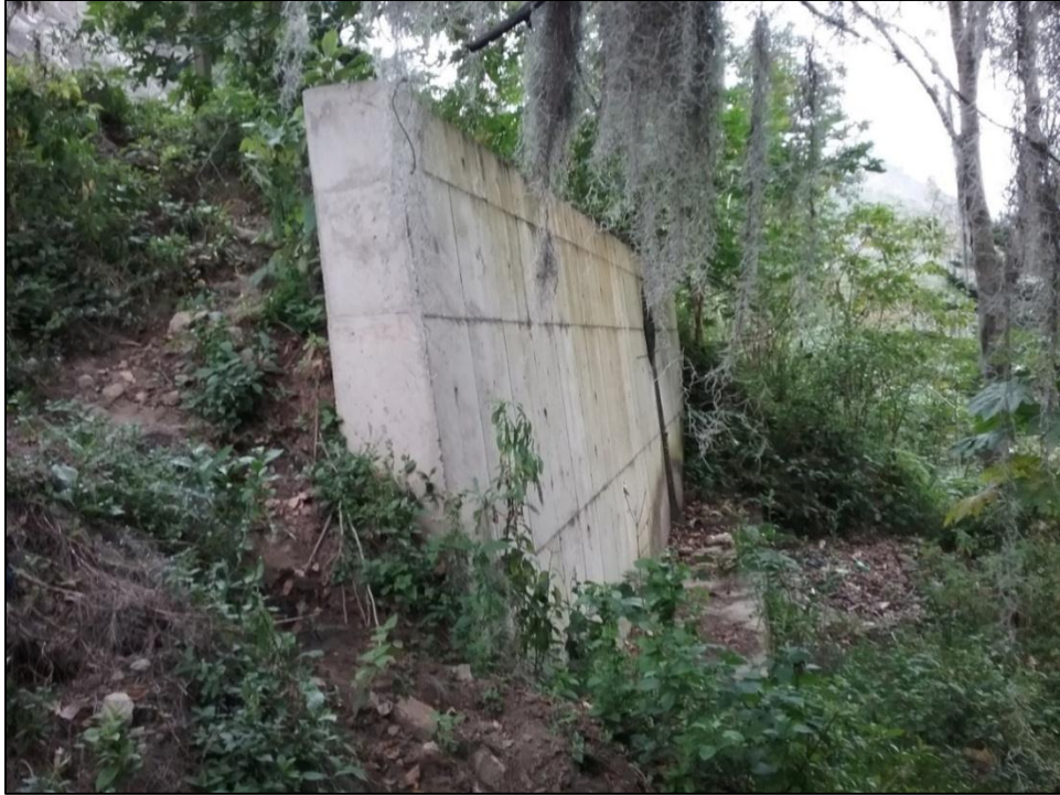
Fotografía 29. Muro de hormigón armado ¿sobre pilotes? (Fuente elaboración propia)
