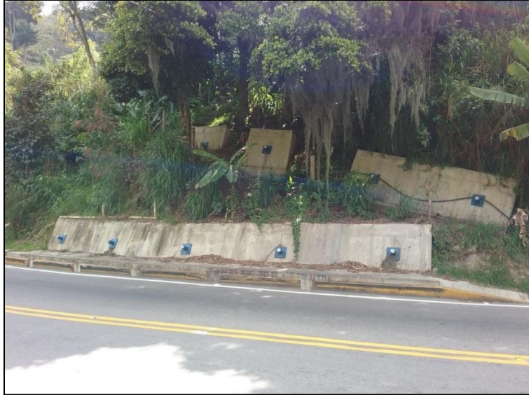
Fotografía 24. Muro anclado en el sitio crítico 9. (Fuente elaboración propia).
