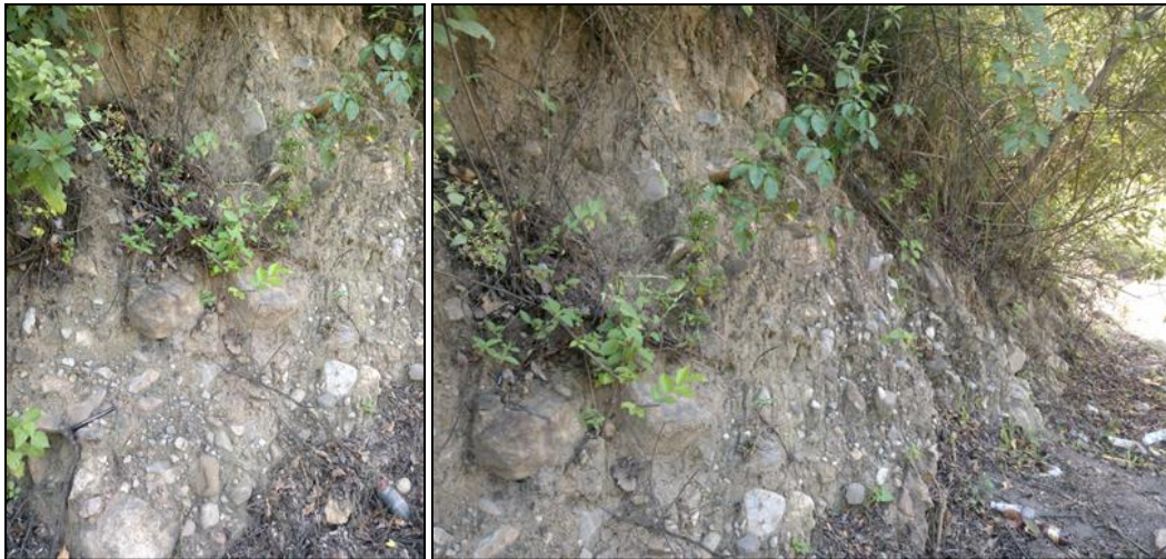
Fotografía 2. Detalle de bloques de arenisca en la terraza aluvial del Sitio crítico 2. (Fuente: Elaboración propia).
