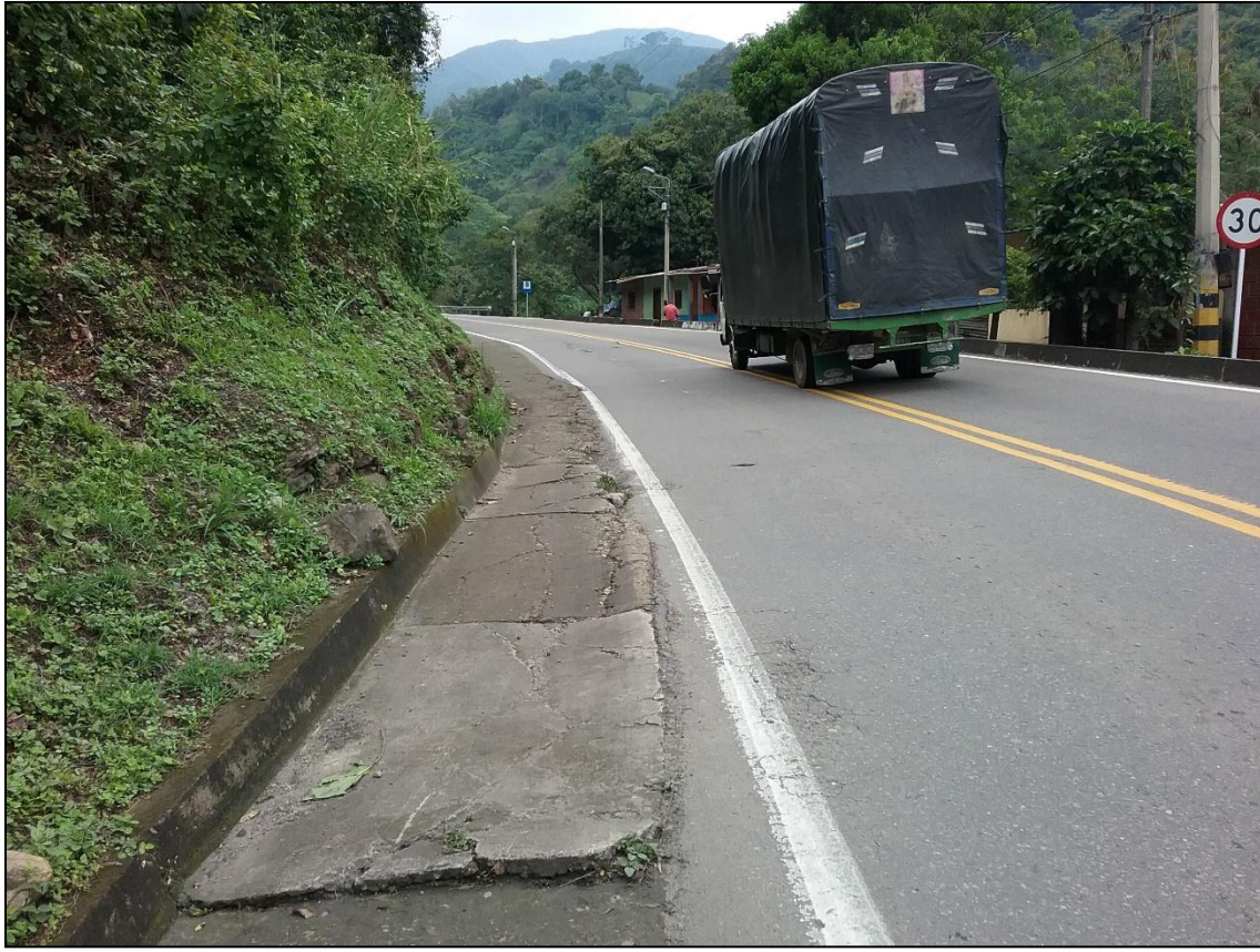
Fotografía 1. Fotografía sitio crítico 1 con levantamiento de pavimento (Fuente: Elaboración propia).
