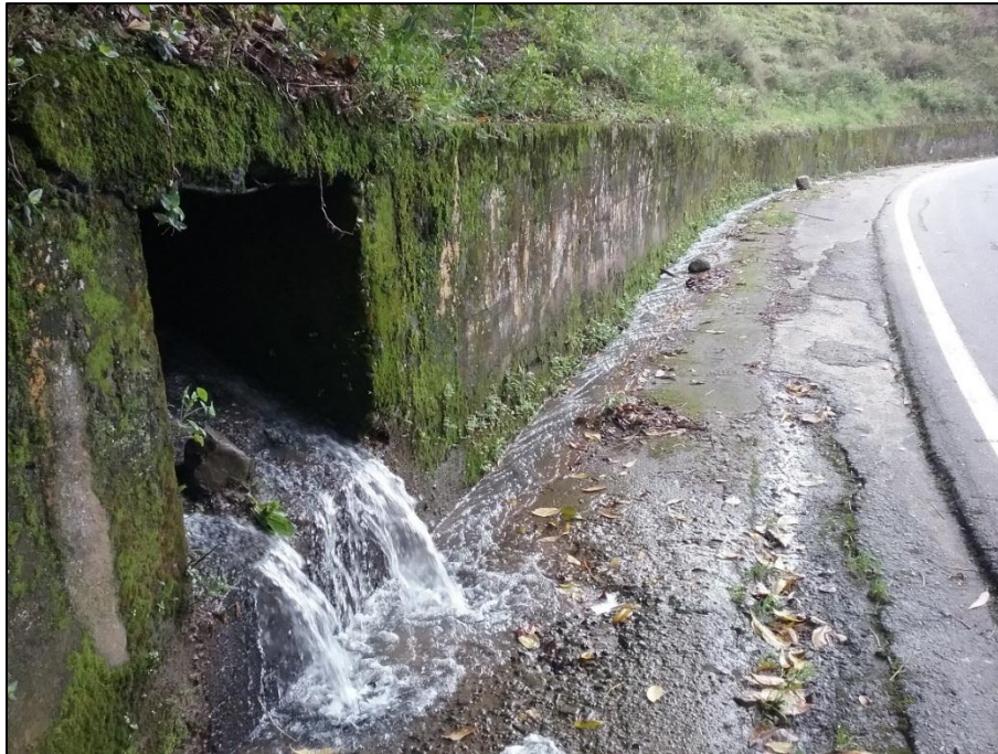
Fotografía 35. Detalle de la alcantarilla. (Fuente: elaboración propia)
