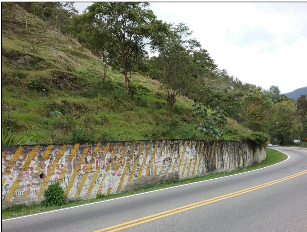
Fotografía 32. Aspecto muro actual (Fuente: elaboración propia)
