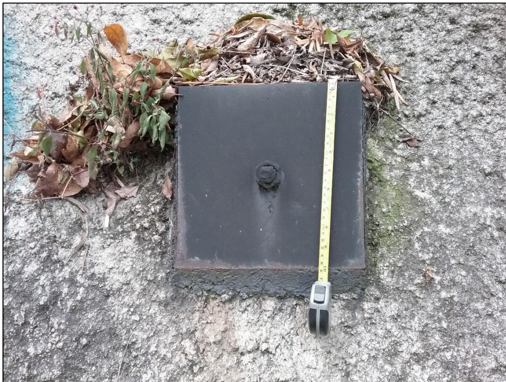
Fotografía 28. Detalle cabeza bulón. (Fuente elaboración propia)
