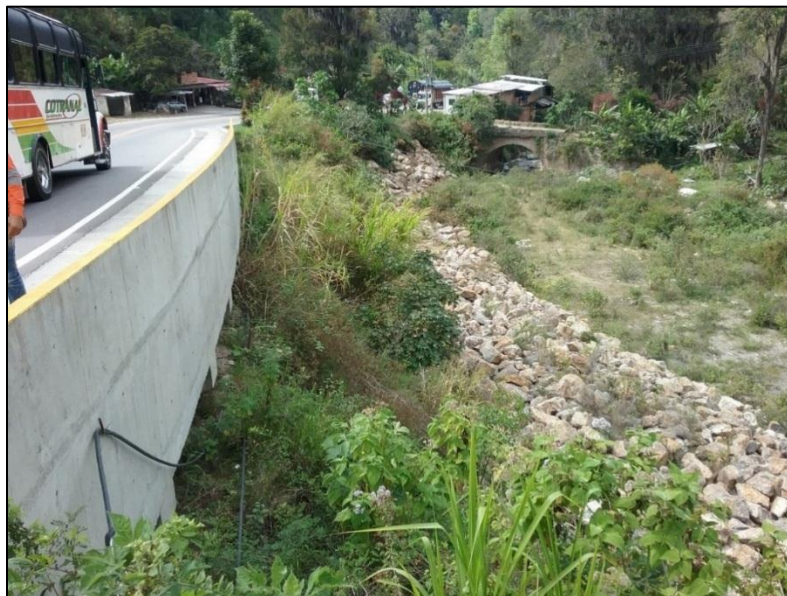
Fotografía 23. Calzada en voladizo y protección del cauce con escollera en el sitio crítico 9. (Fuente elaboración propia).
