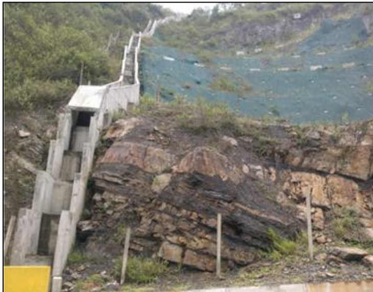
Fotografía 19. Detalle de las cunetas del sitio crítico 7. (Fuente: Elaboración propia).
