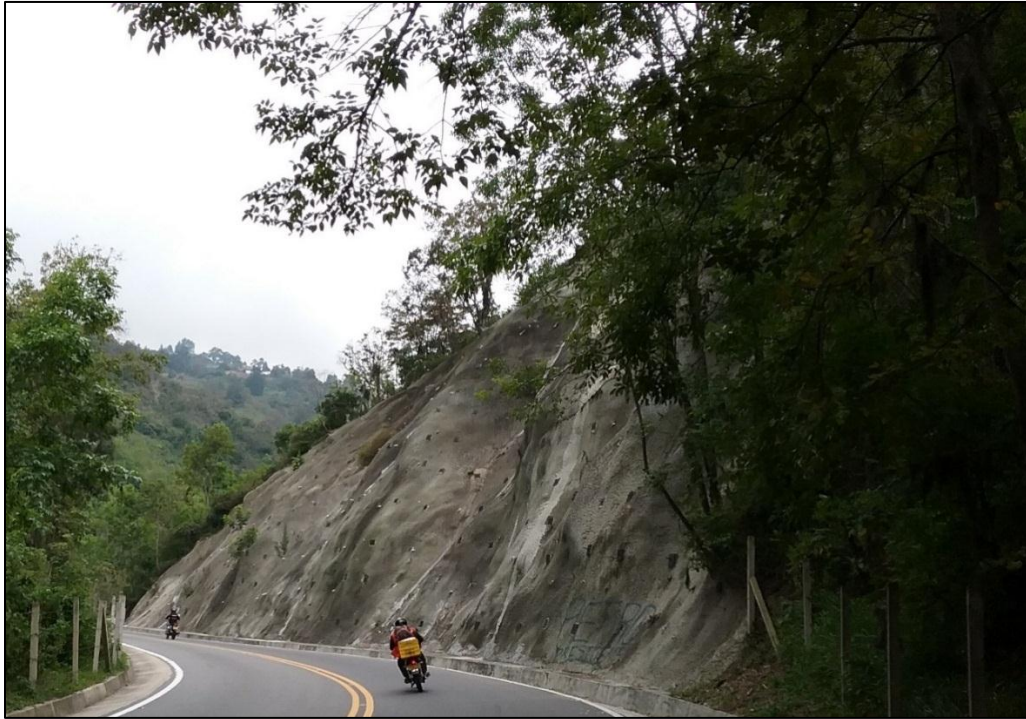
Fotografía 27. Talud bulonado. (Fuente elaboración propia)
