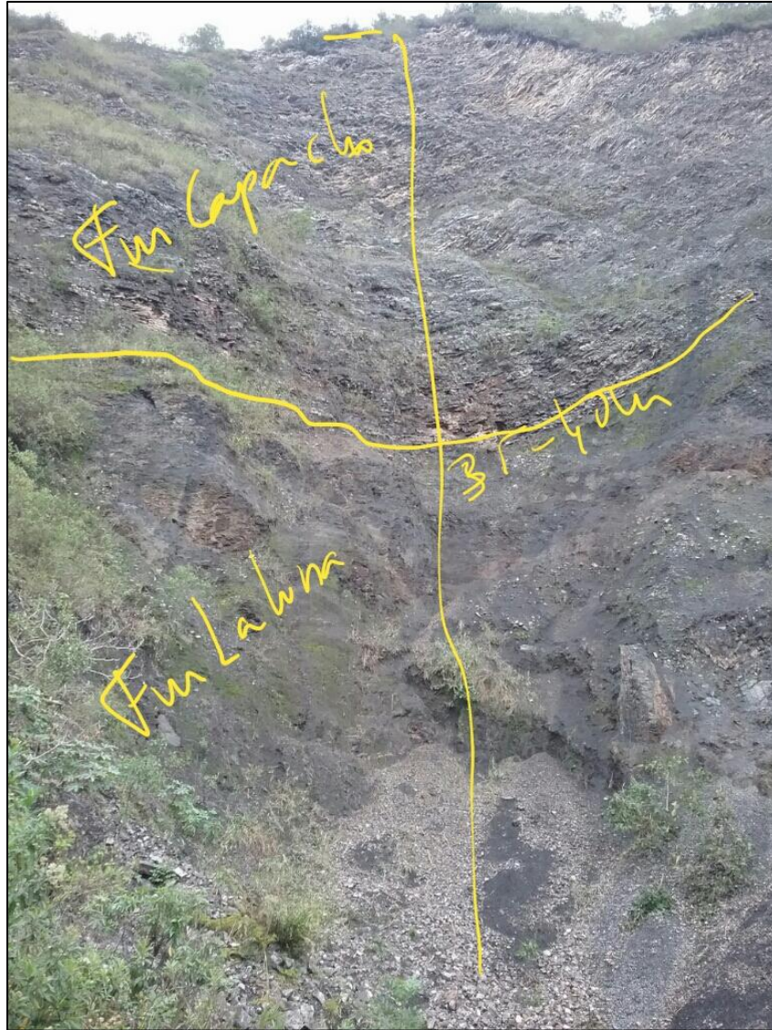
Fotografía 43. Corte del sitio crítico 16. (Fuente: elaboración propia)
