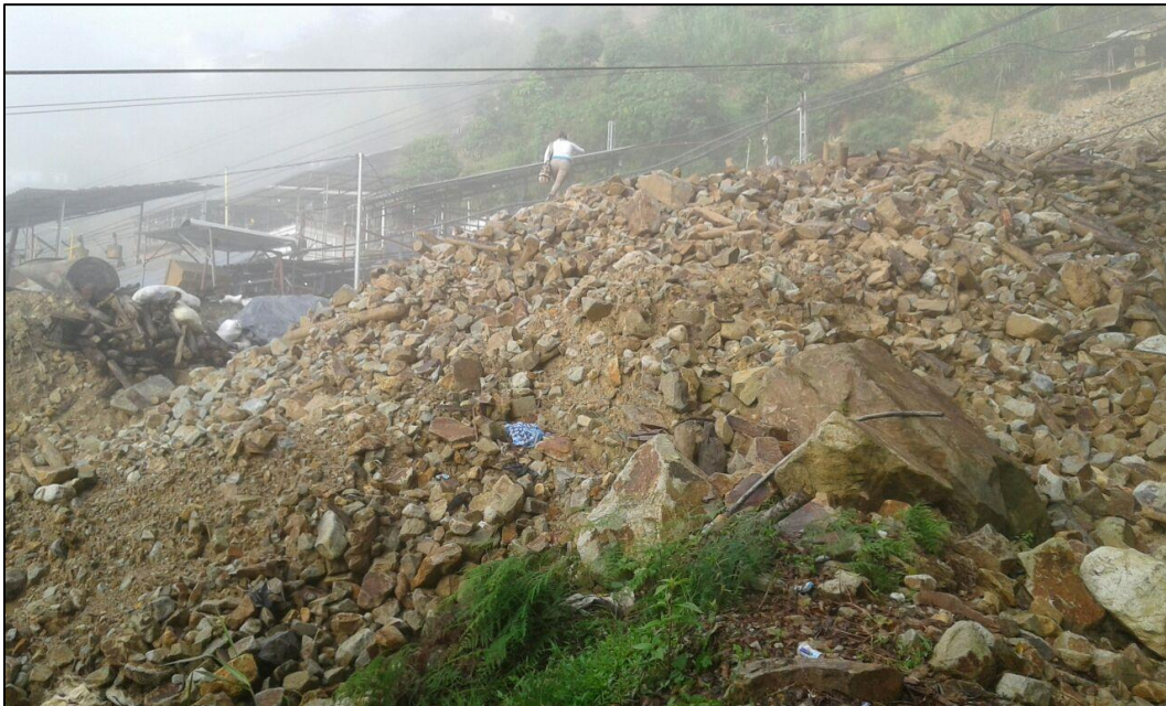
Figura 2. Flujo de escombros, ocasionados por la mala disposición de materiales estériles producto de la minería. Sector de la Plazoleta, Marmato, Caldas.
