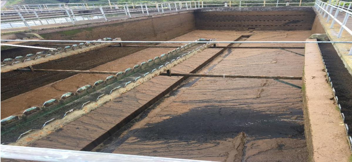
Ilustración 7. Sedimentadores en mantenimiento
