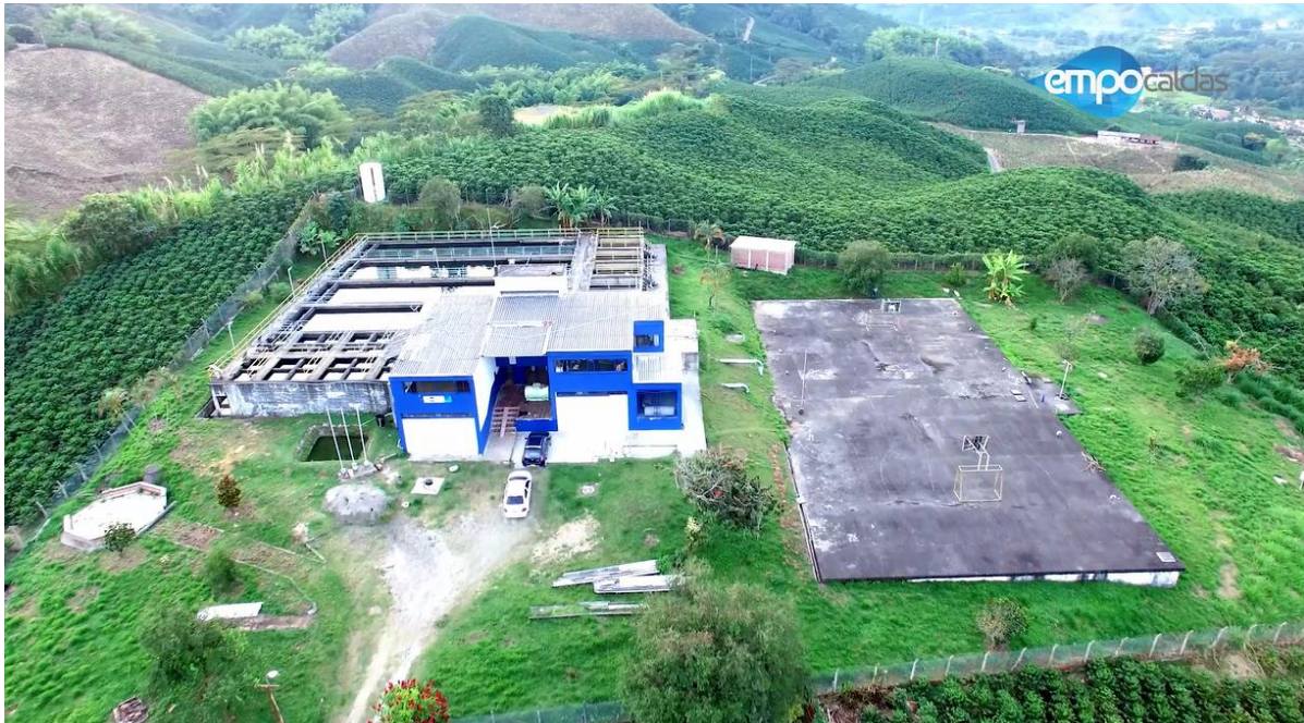
Ilustración 1. Instalaciones de la planta
