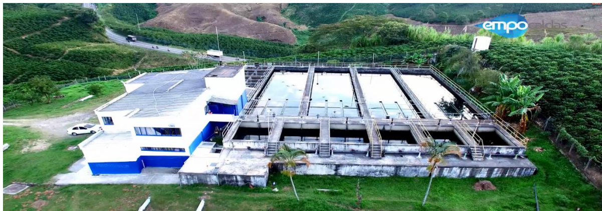
Ilustración 2. Sedimentadores y filtros
