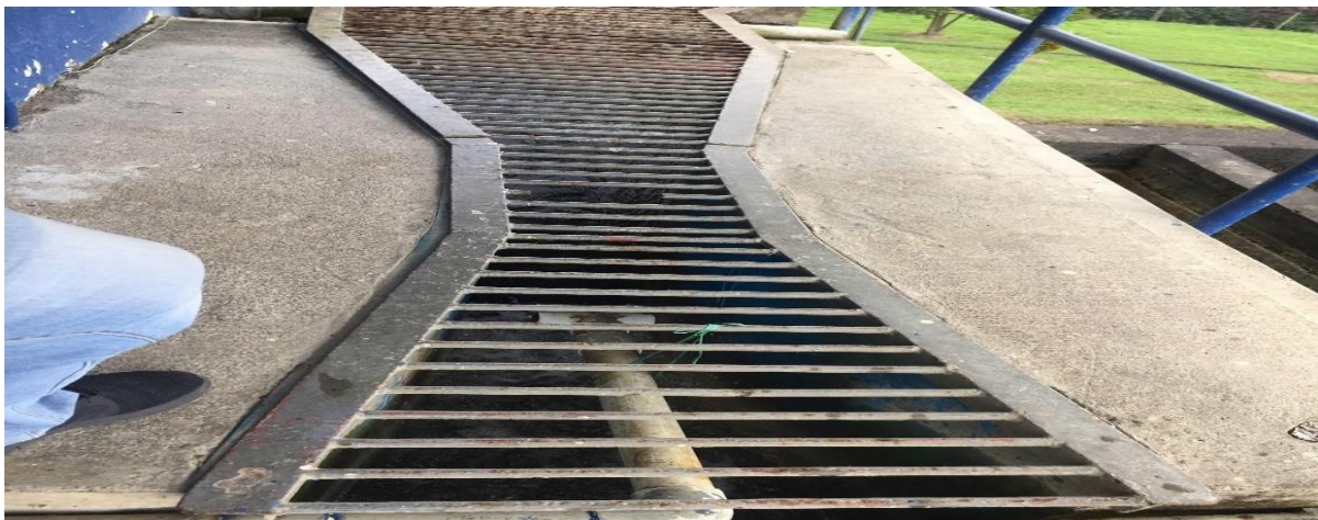
Ilustración 4. Canaleta parshall
