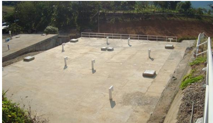
Gráfica 6 Tanque de almacenamiento enterrado
