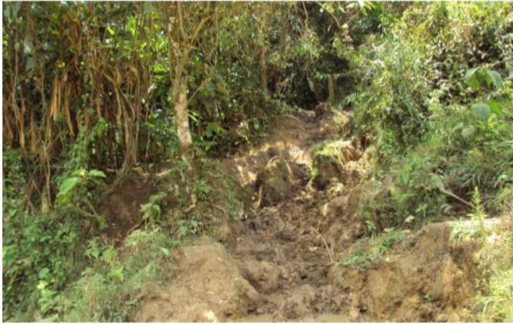
Ilustración 4 Erosión en la parte alta de la microcuenca - Afloramiento Eucaliptus
