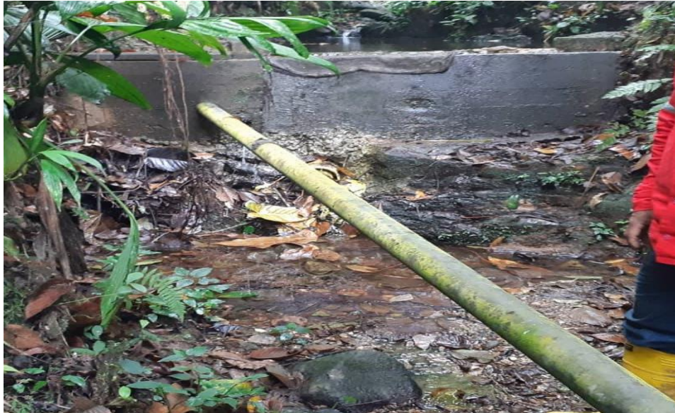
Ilustración 13 Línea de aducción Bocatoma 1- Desarenador.
