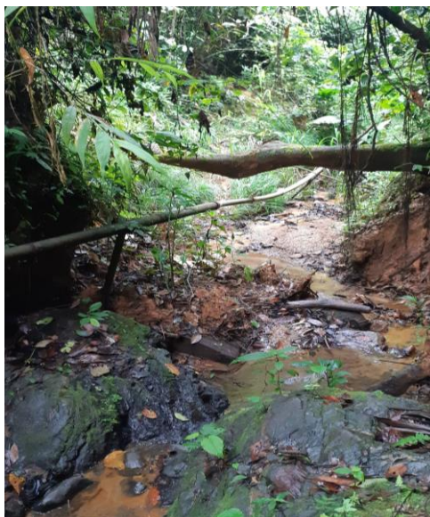
Ilustración 17 Riesgo de daño en tubería de aducción por caída de árbol.
