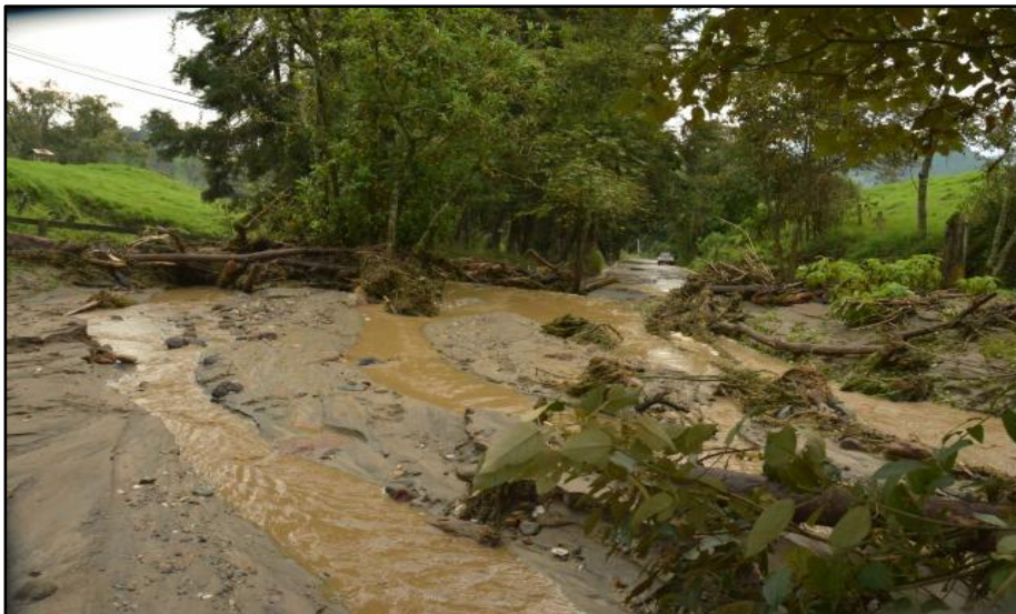
Ilustración 9. Afectación puente en el sector el vergel
