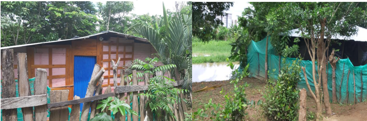
Fotografía 11.7. Viviendas zona homogénea 3
