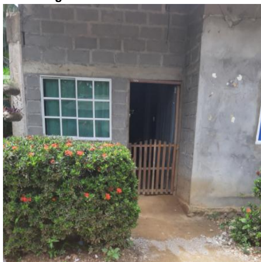
Fotografía 11.5. Viviendas zona homogénea 2
