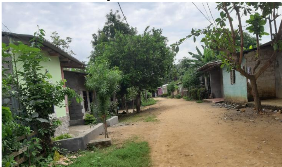
Fotografía 11.4. Edificaciones zona homogénea 2
