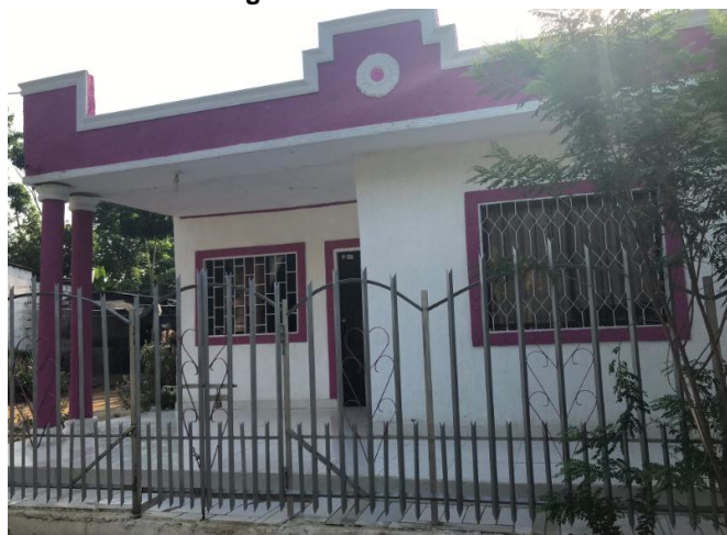
Fotografía 11.3. Edificaciones zona homogénea 1
