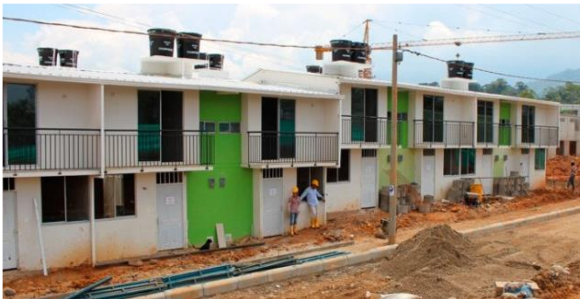
Imagen 4: Construcción proyecto de Vivienda Los Sauces I.
