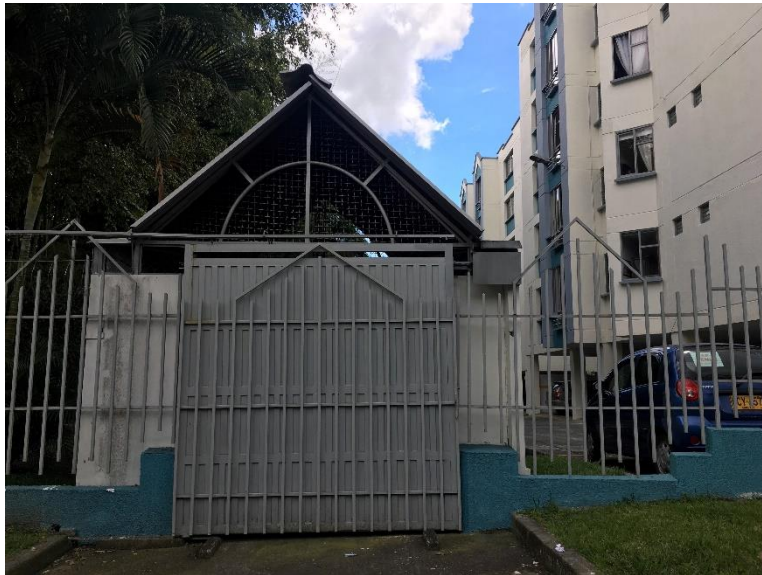
Imagen 5: Área de almacenamiento temporal de residuos sólidos del conjunto residencial La Abadía Fuente: Autor, 2019
