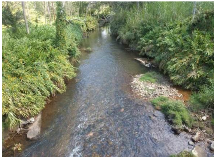
Figura 69. Conformación del cauce -Subtramo zona rural sin meandros
