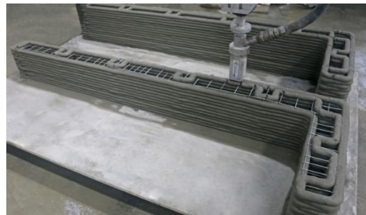
Figura 14. Casa Origami. Proceso de Impresión de Concreto.
