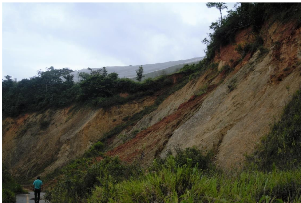
Figura 6. Deslizamientos presentados a lo largo de la vía hacia Buenaventura. Fuente: Elaboración Propia
