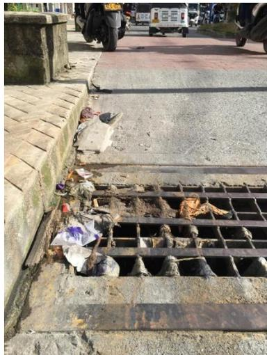
**Imagen N° 12:** Obstrucción con RS de Rejillas de alcantarillado en el Bulevar los pinos
