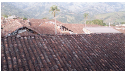
Figura 34. Cubiertas en teja de barro
