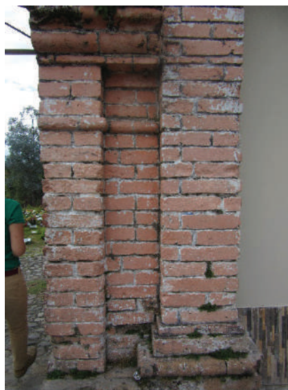
Figura 90. Construcción tradicional de cal y canto
