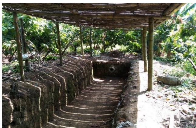
Figura No. 19: Montaje del techo en esterilla de guadua
