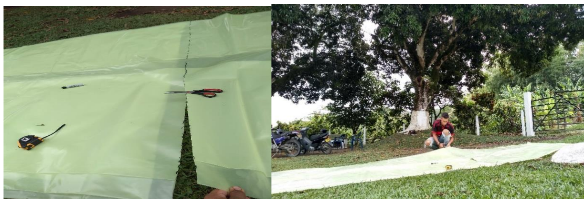
Figura No. 21: Aislamiento de plástico del biodigestor
