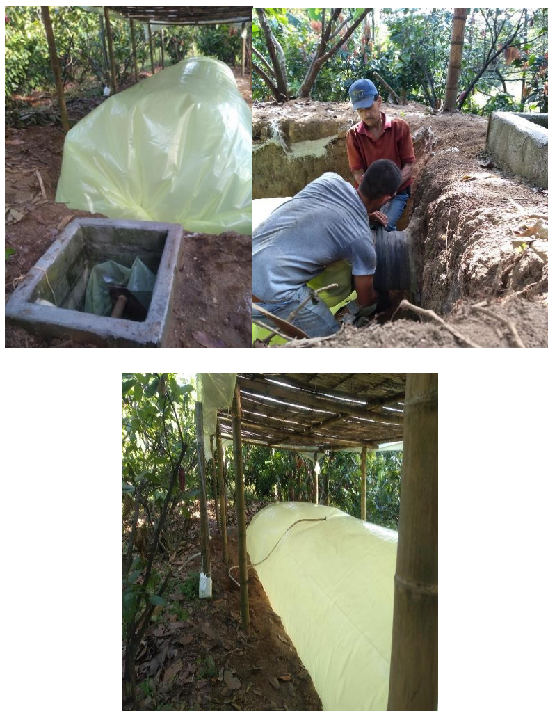
Figura No. 23: Montaje y prueba del reactor
