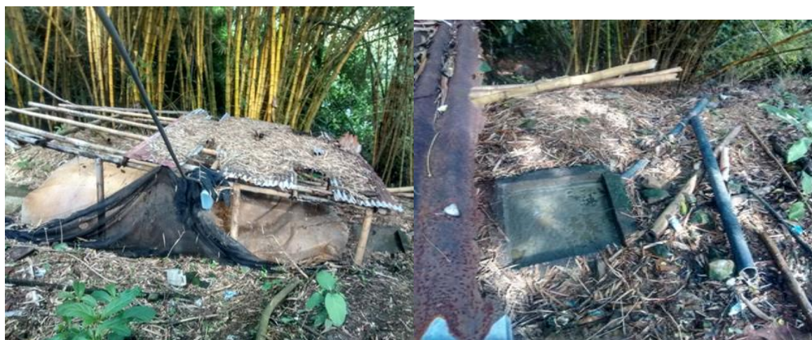
Figura No. 16: Desgaste de un biodigestor que no cumple con directrices de Corpocaldas
