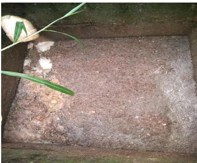
Figura No. 24: Primera caja de entrada con materia orgánica
