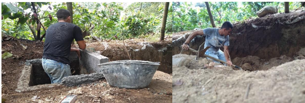
Figura No. 20: Adecuación de cajas de entrada y salida biodigestor
