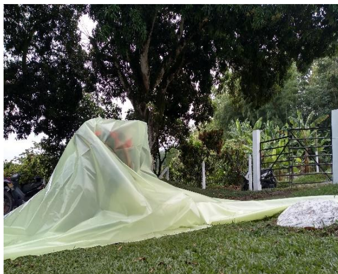
Figura No. 22: Instalación de acople y plástico reforzado
