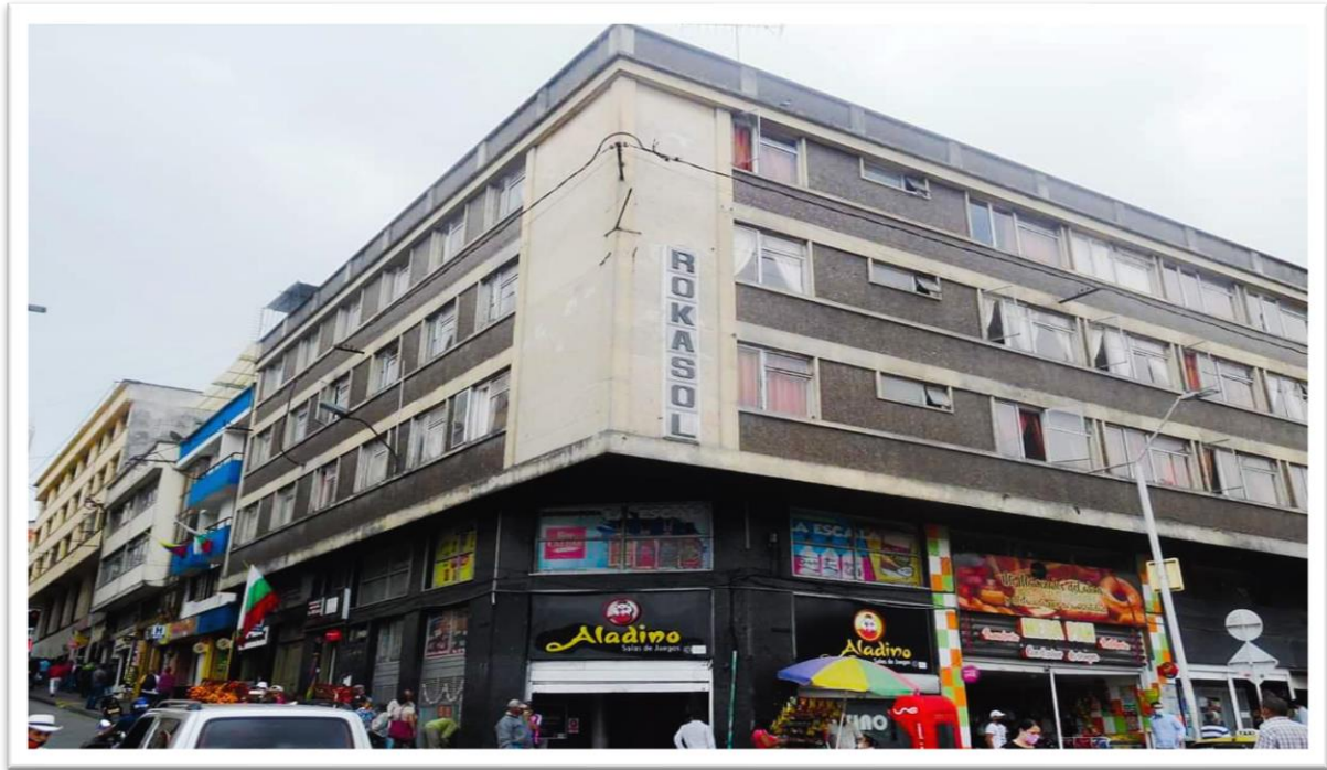
Figura 6: Vista Frontal del Hotel Rokasol.
