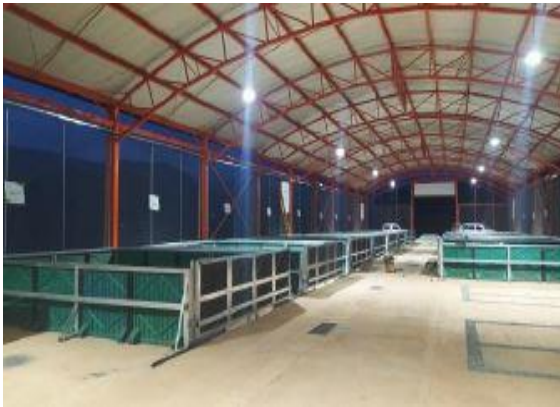
Ilustración 16: Planta de compostaje, municipio Andes (15 Ton/día) Fuente: Earthgreen
