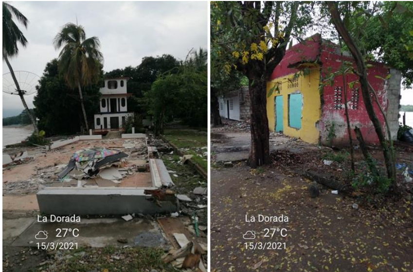
Imagen 62. Proceso de demolición de asentamientos irregulares correspondientes a viviendas y establecimientos comerciales que se encuentran en la faja de protección ambiental del río grande de la Magdalena. Fuente: Elaboración propia- Gobernación de Caldas- INGECON.
