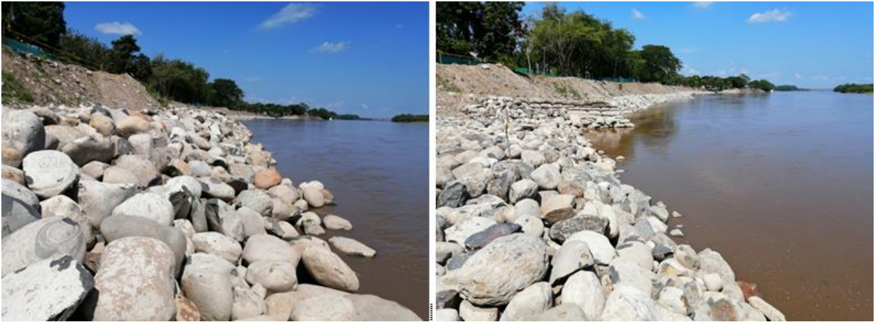
Imagen 57. Base del enrocado (Rip-Rap) Finalizado. Fuente: Elaboración propia-Gobernación de Caldas-INGECON.
