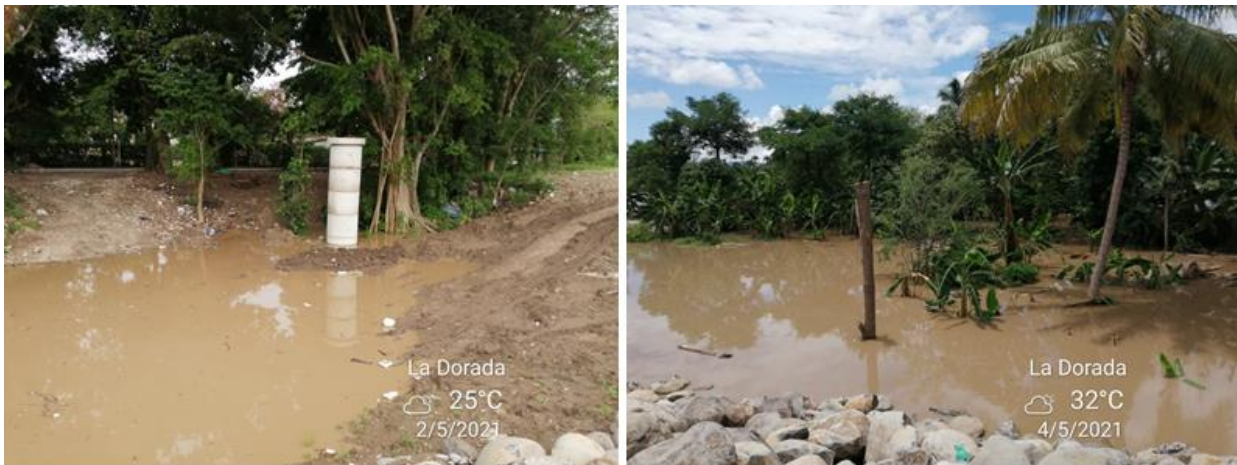
Imagen 72. Acumulación de aguas lluvias hacia la parte interna del enrocado, áreas susceptibles a rellenar en la fase de estructuración y diseños de Malecón.
