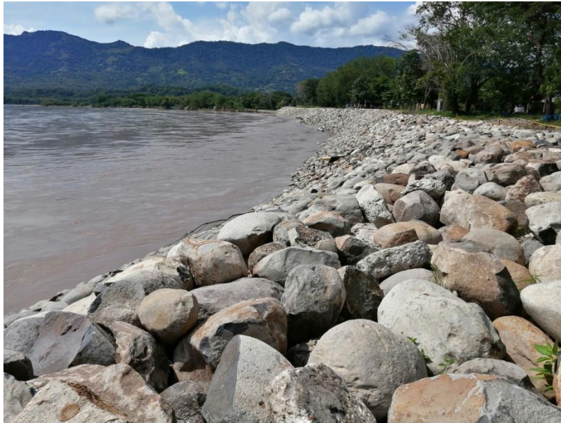
Imagen 107. Panorámica construcción del enrocado - Rip Rap. Fuente: Elaboración propia.
