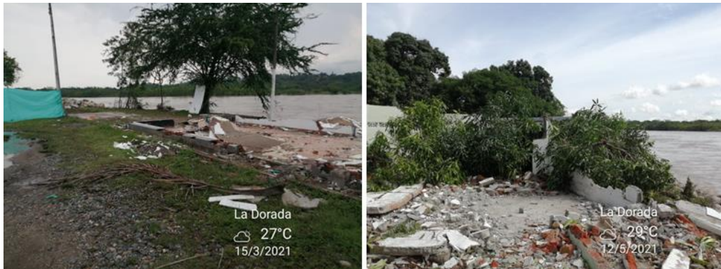
Imagen 63. Proceso de demolición de asentamientos irregulares. Fuente: Elaboración propia-Gobernación de Caldas-INGECON.
