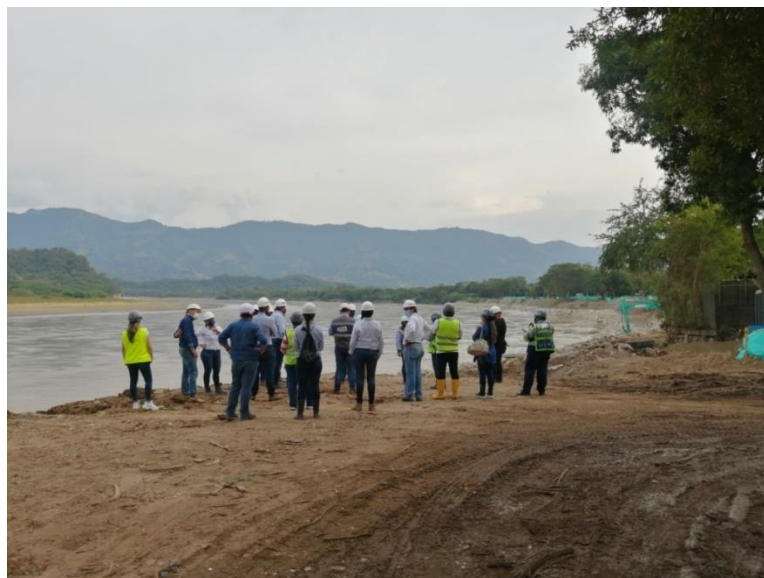
Imagen 93. Recorrido de campo y verificación de avances de los Comités de Seguimiento de Obra (CSO) integrado por Interventoría, contratista, supervisores. Fuente: Elaboración propia.
