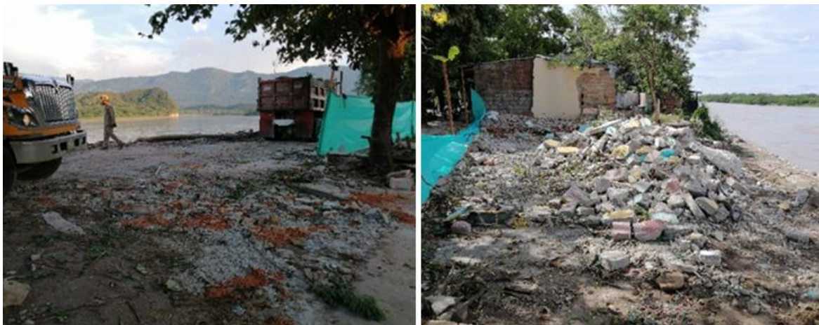
Imagen 68. Viviendas demolidas ubicadas sobre la faja de protección ambiental del Río Magdalena, fue demolida y reubicada en mejores condiciones de vida. Izq. Alexander López Lasso. Der Miguel Angel Moreno. Fuente: Gobernación de Caldas-Alcaldía de La Dorada, Construcción obra de mitigación.
