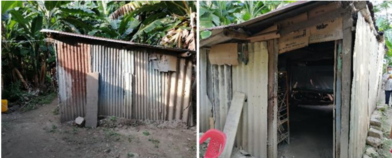
Imagen 65. Vivienda del señor José Antonio Morales, sobre la faja de protección ambiental del Río Magdalena, fue demolida y reubicada en mejores condiciones de vida. Fuente: Gobernación de Caldas-Alcaldía de La Dorada, Construcción obra de mitigación.
