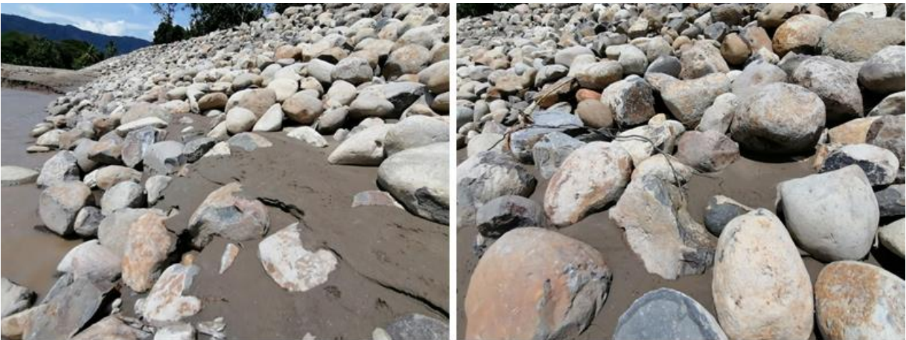
Imagen 74. Procesos sedimentarios, acumulación de sedimentos finos en los espacios del enrocado, disminuye porosidad y aumenta cohesión de las rocas.
