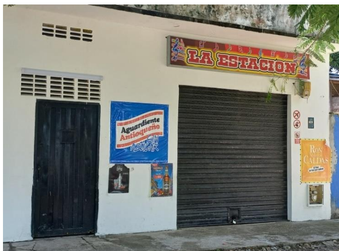
Imagen 109. Adecuación de viviendas con fines comerciales, venta de licores. Fuente: Elaboración propia.
