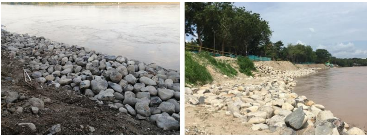
Imagen 56. Proceso de construcción de la base del enrocado (Rip-Rap). Fuente: Elaboración propia-Gobernación de Caldas-INGECON.
