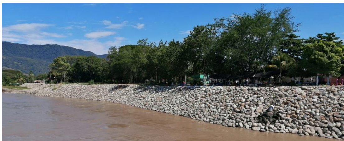
Imagen 96. Panorámica del estado actual de la obra de construcción del Rip Rap. Fuente: Elaboración propia.
