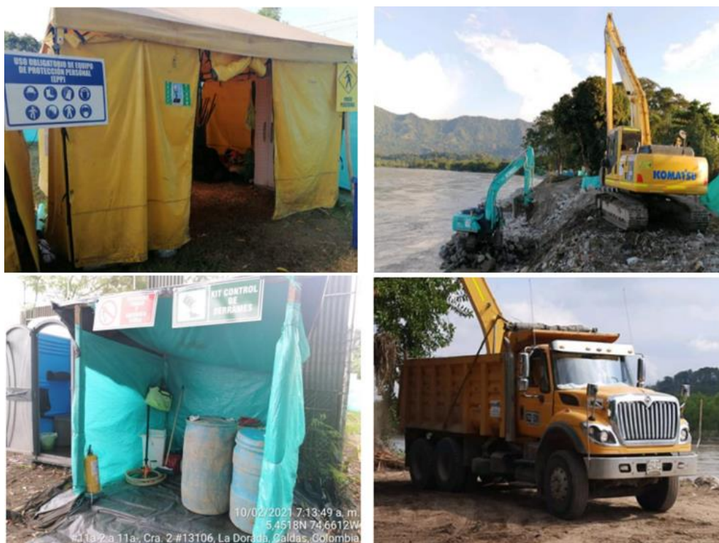
Imagen 78. Instalaciones temporales, maquinarias y vehículos empleados en la construcción del Rip Rap.
