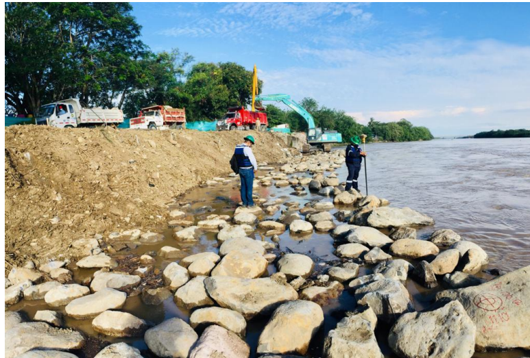
Imagen 90. Proceso de Control, topográfico, Calculo de volúmenes de roca. Fuente: Elaboración propia – INGECON.
