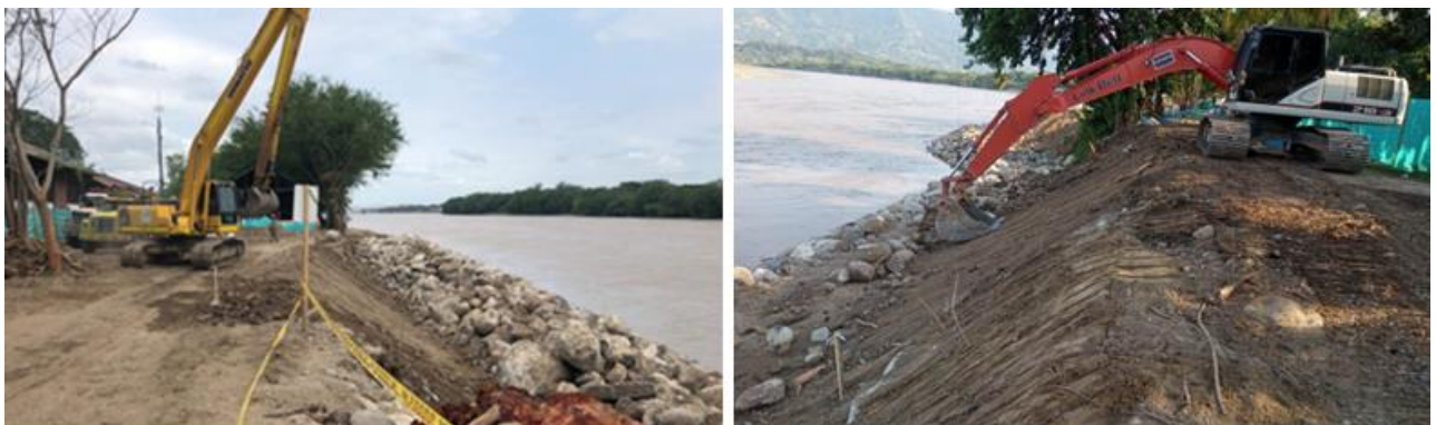
Imagen 58. Adecuación del terreno, Retiro de material contaminado y perfilado del talud. Fuente: Elaboración propia-Gobernación de Caldas-INGECON.
