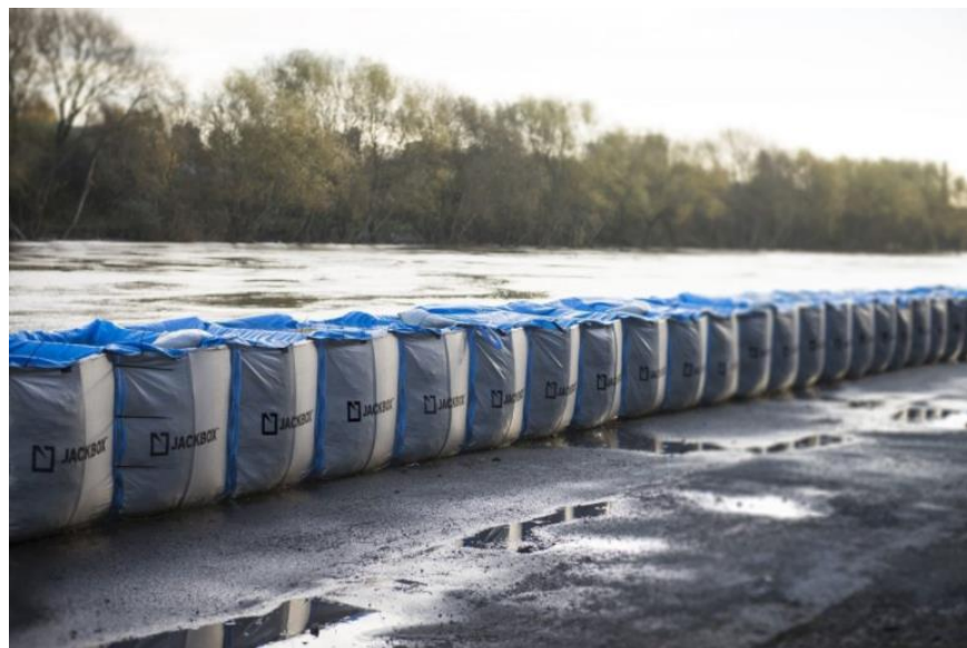
Imagen 37. Muro de tierra estabilizado. Fuente: https://floodlist.com/protection/hesco-supplies
