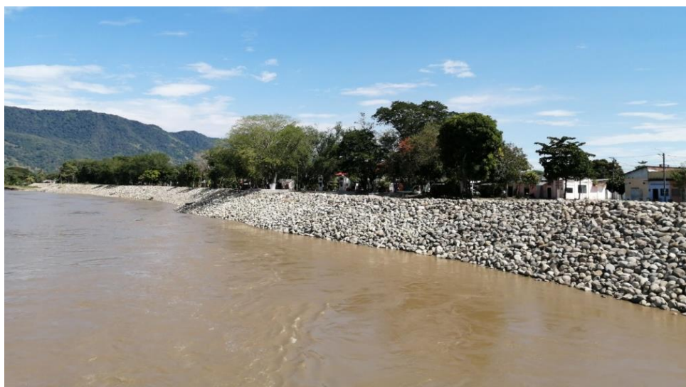
Imagen 101. Panorámica de la construcción del enrocado, Cumplimiento al Objetivo de desarrollo sostenible # 9. Como infraestructura fundamental para lograr desarrollo sostenible en la región del magdalena medio. Fuente: Elaboración Propia.
