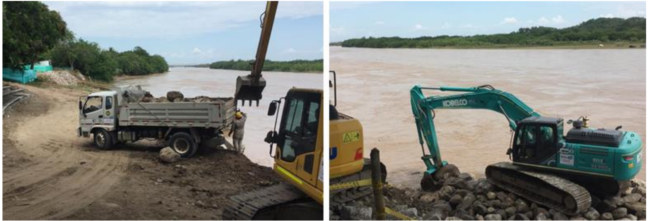
Imagen 54. Construcción de la base del enrocado, límite de la ribera y el cauce del río. Fuente: Elaboración propia-Gobernación de Caldas-INGECON.
