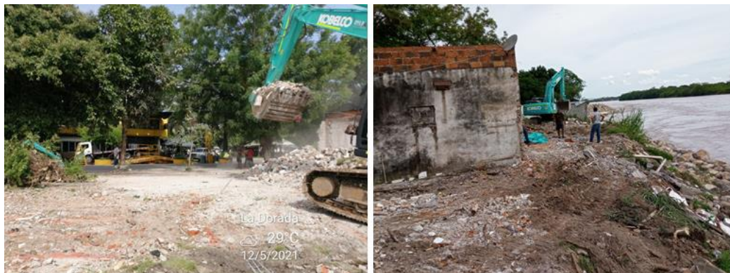
Imagen 64. Proceso de demolición de asentamientos irregulares. Fuente: Elaboración propia-Gobernación de Caldas-INGECON.
