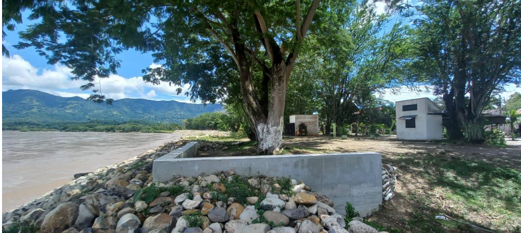
Imagen 80. Construcción final del muro para la contención y conservación de especies arbóreas. Fuente; Elaboración propia - Gobernación de Caldas
