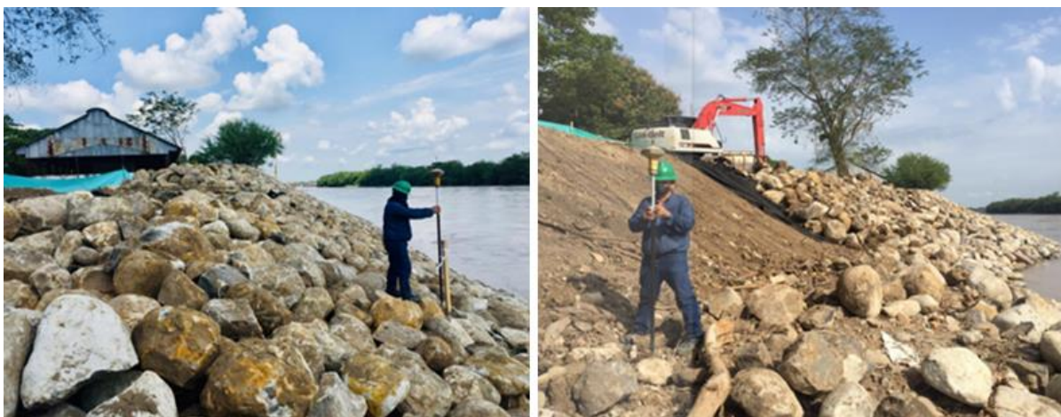
Imagen 60. Avances en la construcción de la obra para la mitigación de riesgo de socavación. Fuente: Elaboración propia – Gobernación de Caldas.
