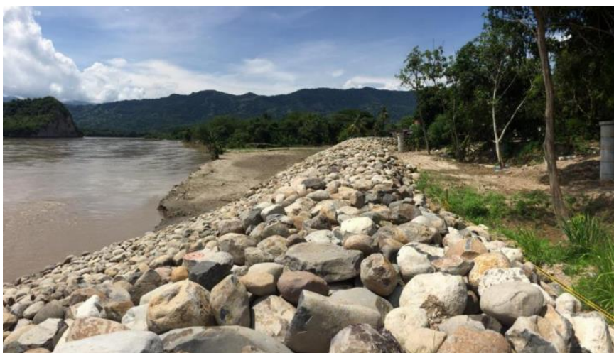
Imagen 50. Construcción atendiendo los lineamientos ajustados y cota máxima de inundación, sector de Bucamba - Tramo Sur del proyecto de mitigación. Fuente: Propia Supervisión al contrato de obra.
