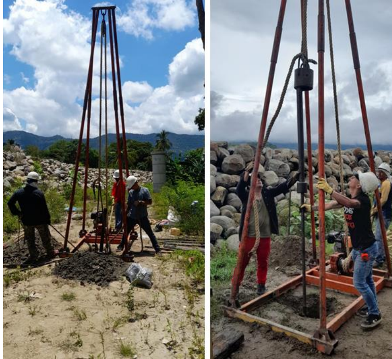
Imagen 8. Perforaciones para estudios de suelos a lo largo del lineamiento del diseño del enrocado Rip Rap. Fuente: Gobernación de Caldas- Alcaldía La Dorada - VACAB.
