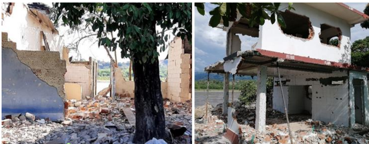
Imagen 69. Viviendas demolidas ubicadas sobre la faja de protección ambiental del Río Magdalena, fue demolida y reubicada en mejores condiciones de vida. Izq. Martha Ruth Orozco. Der. Luis Carlos Melgarejo. Fuente: Gobernación de Caldas-Alcaldía de La Dorada, Construcción obra de mitigación.
