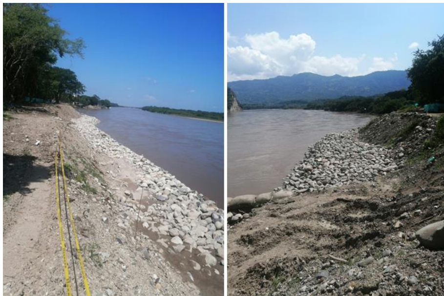
Imagen 55. Proceso de construcción de la base del enrocado (Rip-Rap). Fuente: Elaboración propia-Gobernación de Caldas-INGECON.
