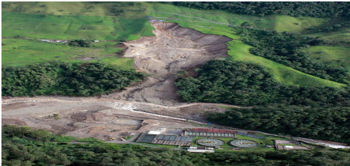
Figura 18. Deslizamiento en la Planta Luis Prieto en Manizales, a causa de las altas precipitaciones.
