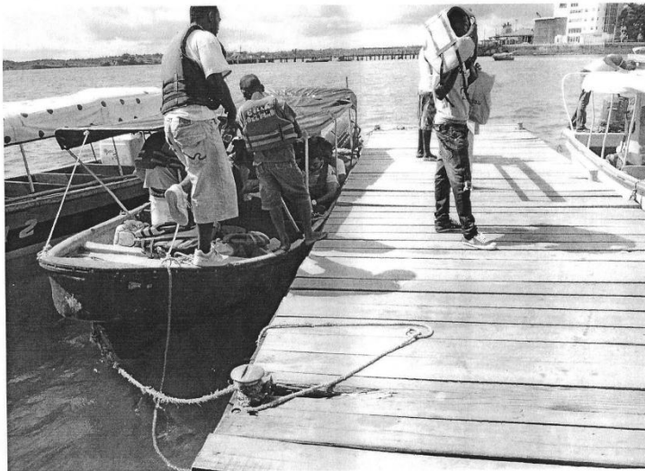
Figura 14. Amarradero de hierro del muelle turístico de Buenaventura. Fuente: equipo de investigación.
