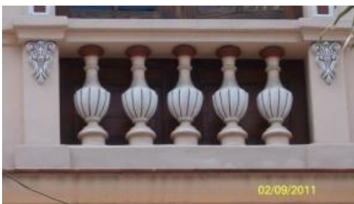
Fotografía 17. Detalle de los balcones.
