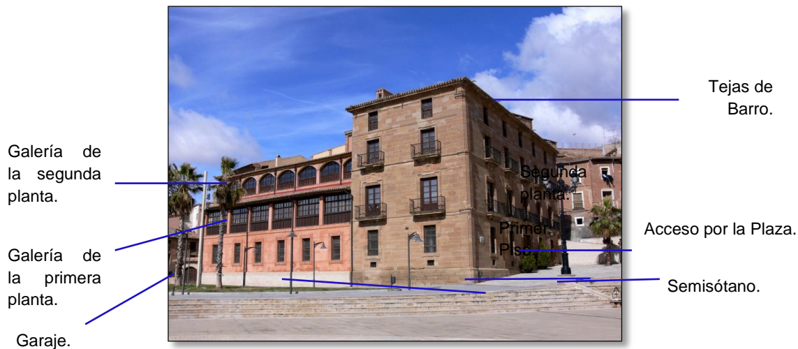
Fotografía 8. Perspectiva del palacio Episcopal de Calahorra.
