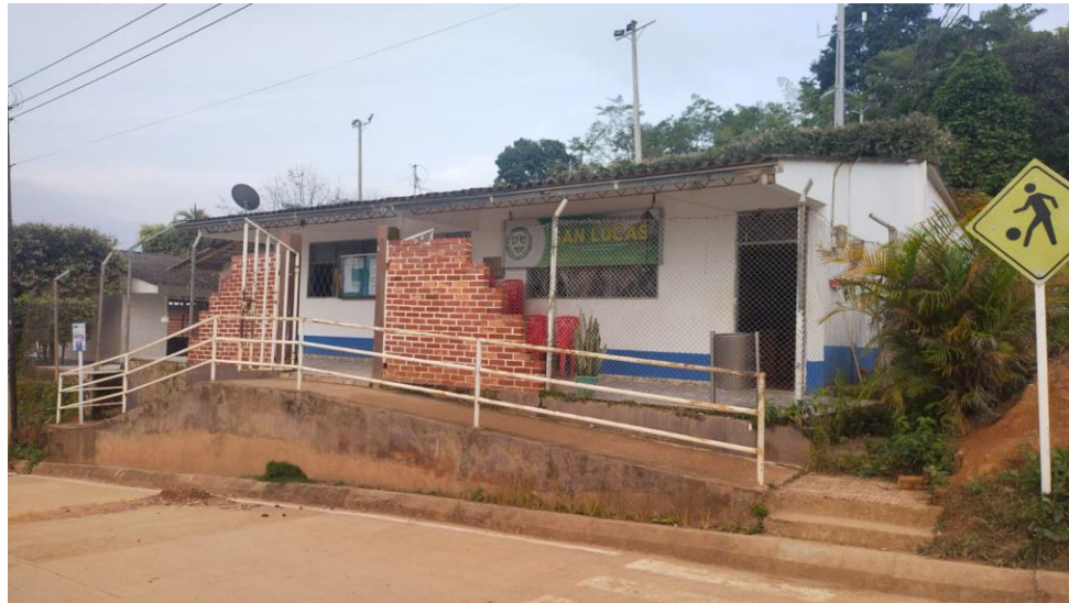
Figura 2. Fachada de la I. E San Lucas
