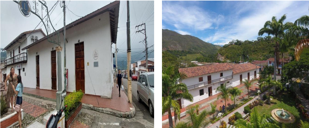
Figura 10. Registro fotográfico casa de la cultura
