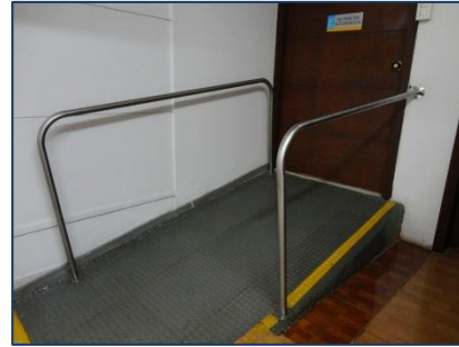
BARANDAS RAMPAS DE ACCESO
