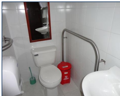
BARANDAS EN BAÑOS
