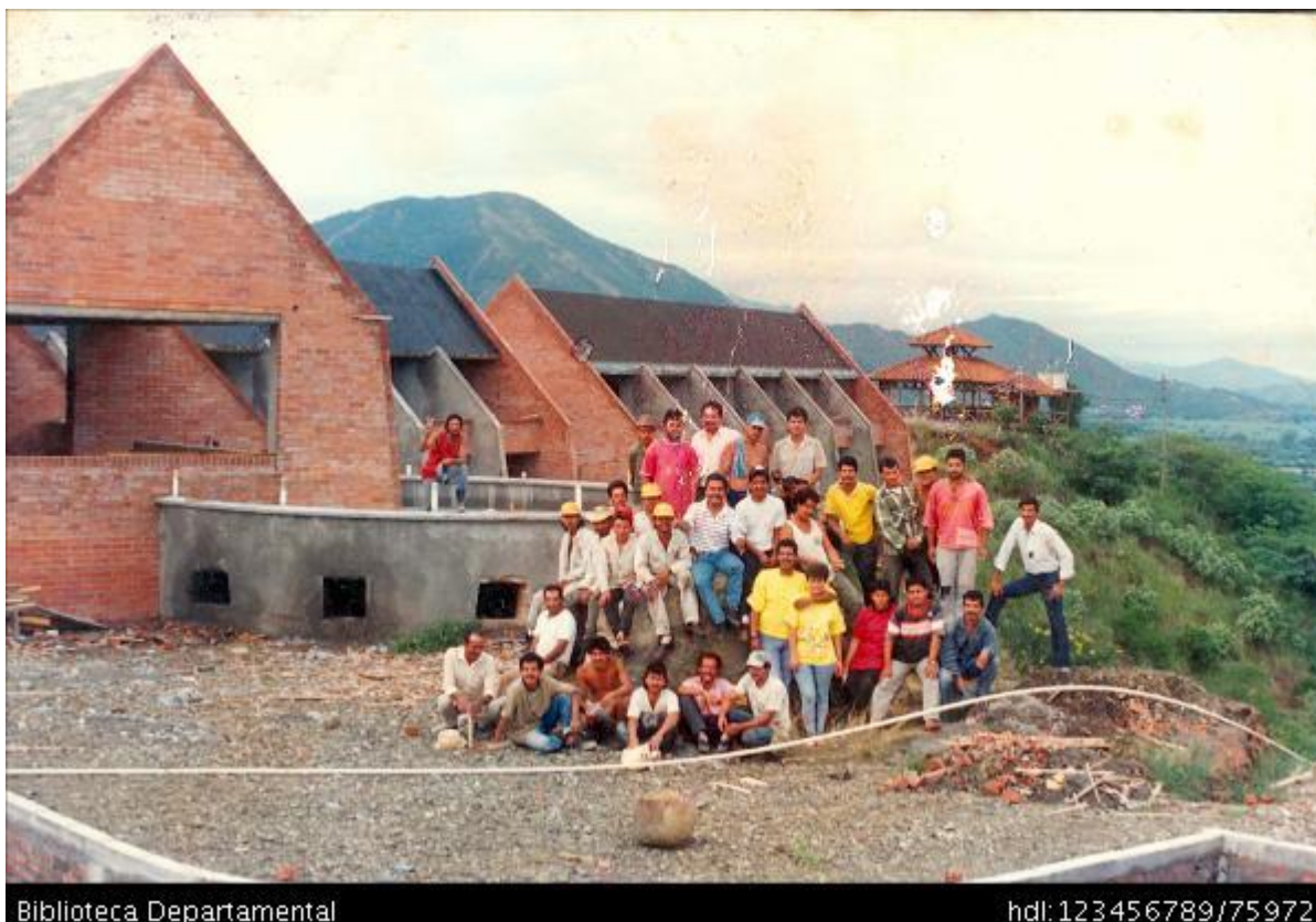
Ilustración 5. Construcción hotel los viñedos, 1990.
