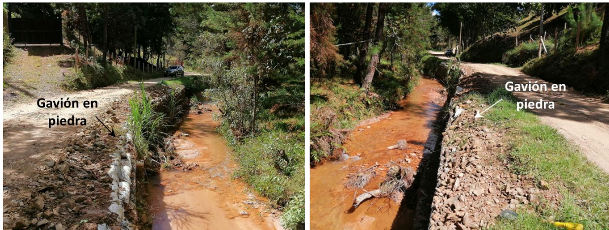
Figura 15. Intervención con gavión en piedra en la quebrada Guacirú.
