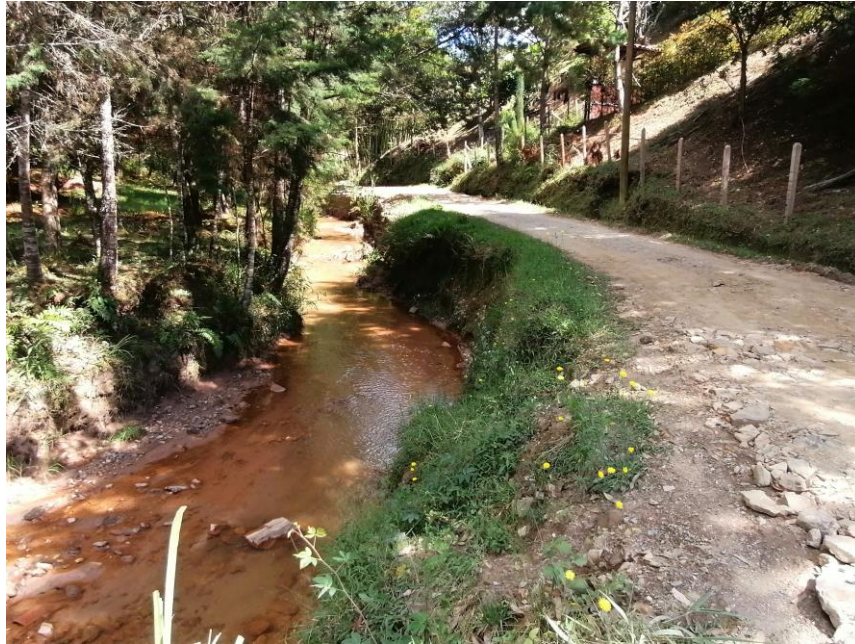
Figura 3. Socavación de la quebrada Guacirú en la vía veredal.
