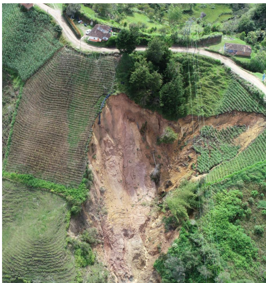
Figura 4. Vista general de la cárcava El Carmelo.
