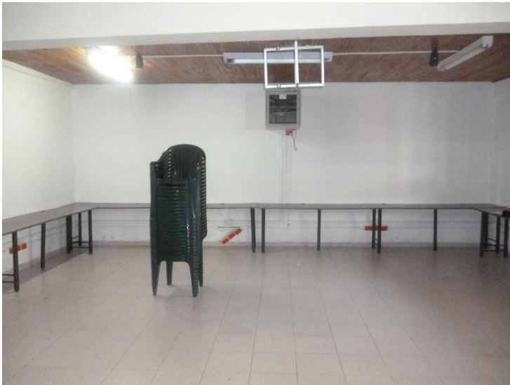
Después Adecuación del aula
