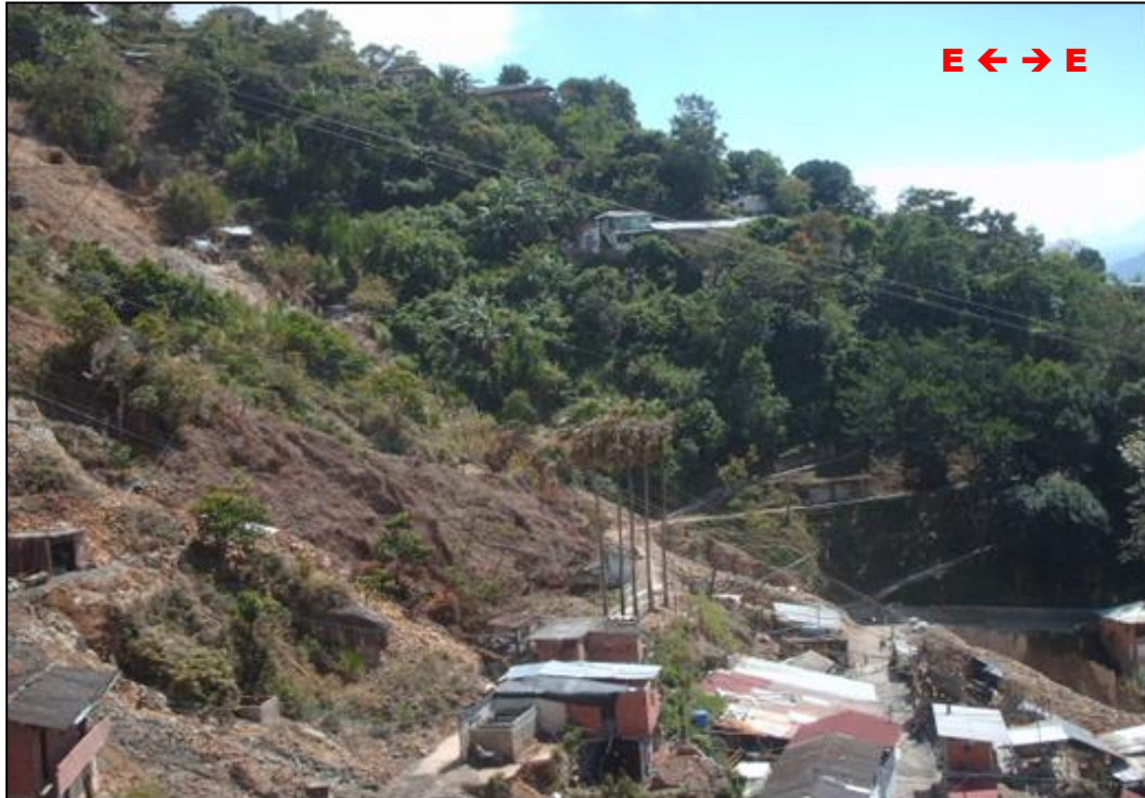
Fotografía 7. Antigo sector urbano (zona de riesgo no mitigable). Fuente propia. 2012
