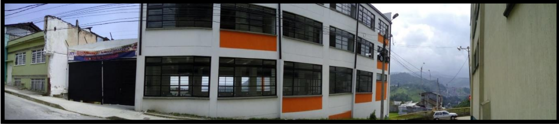
Fotografía 102. Panorámica fachada Escuela Instituto Manizales
