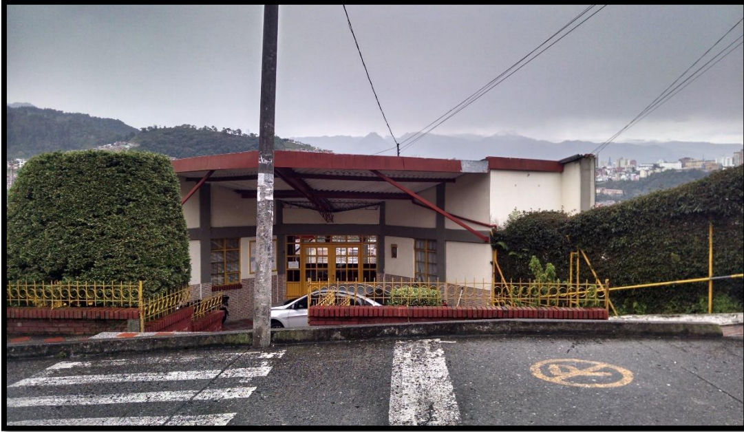
Fotografía 151. Panorámica fachada Escuela Fe y Alegría Caribe
