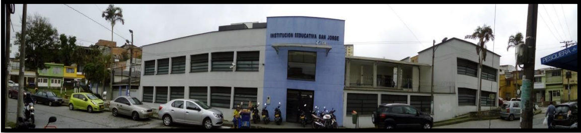
Fotografía 48. Fachada Institución Educativa San Jorge
