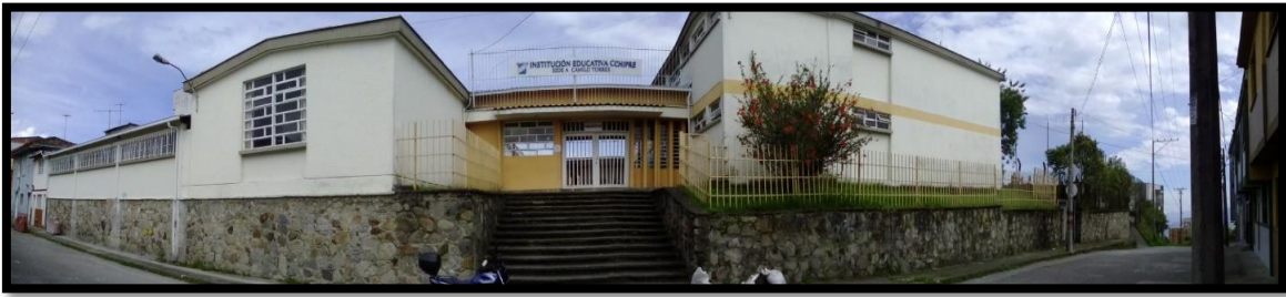
Fotografía 113. Panorámica fachada Institución Educativa Camilo Torres
