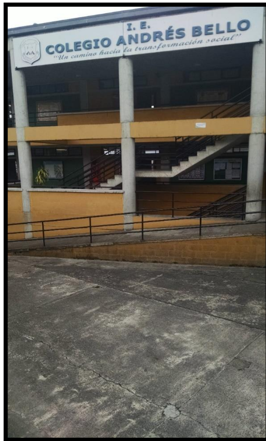
Fotografía 5. Fachada Instituto Educativo Colegio Andrés Bello Nevado
