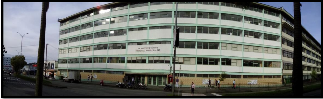
Fotografía 145. Panorámica fachada Instituto San Francisco José De Caldas
