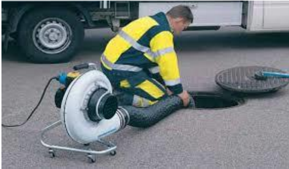
Figura 9. Ventilación en un Espacio Confinado
