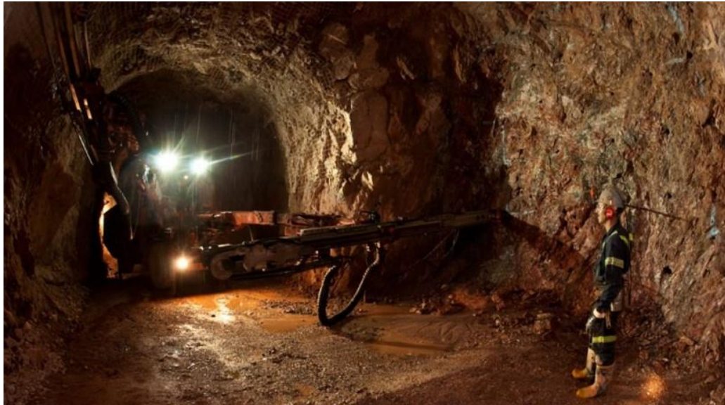
Figura 7. Espacio confinado Cerrado
