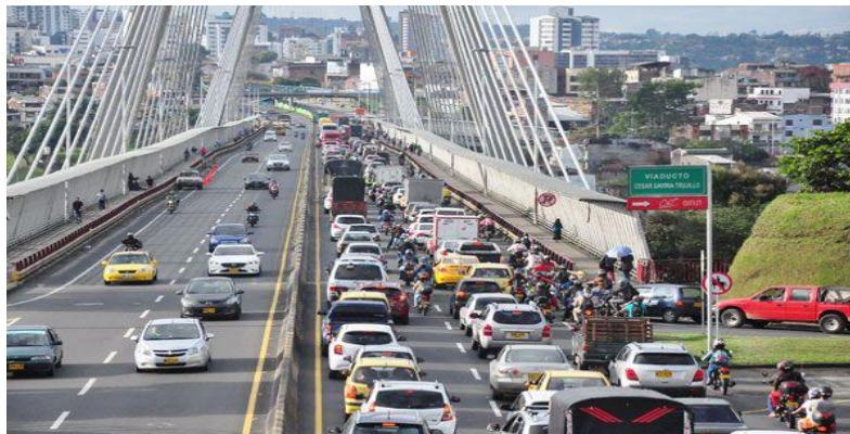
Foto No 6 congestión vehicular viaducto Dosquebradas- Pereira
