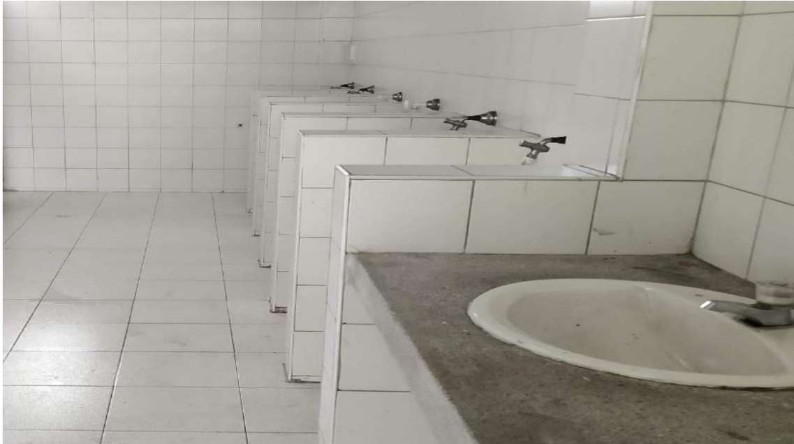
Figura 13. Baños del piso 1 Fuente: Propia
