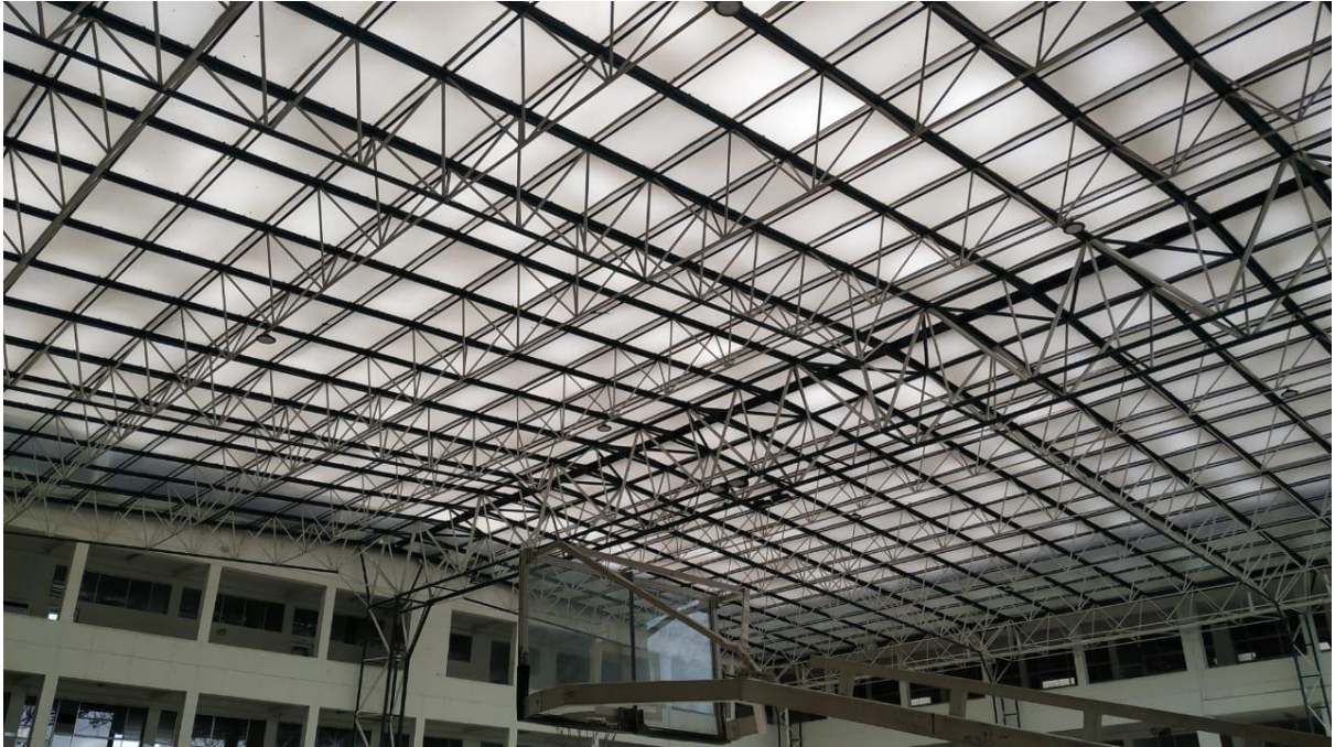
Figura 15. Vista inferior de la cobertura de la losa deportiva Fuente: Propia
