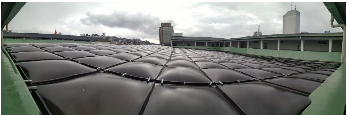
Figura 16. Vista superior de la cobertura de la losa deportiva Fuente: Propia
